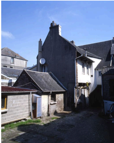
La maison Landot, Grande Rue, vue depuis la cour. Phot. Marie-Laure Monnehay-Vulliet IVR22_20058001155XA
