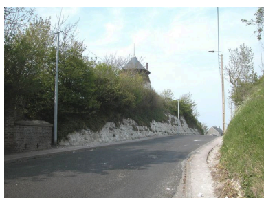
La rue Charles-Bréhamet, reliant le Bourg-d'Ault au quartier des Quatre-Rues. Phot. Elisabeth Justome IVR22_20058003342NUCA
