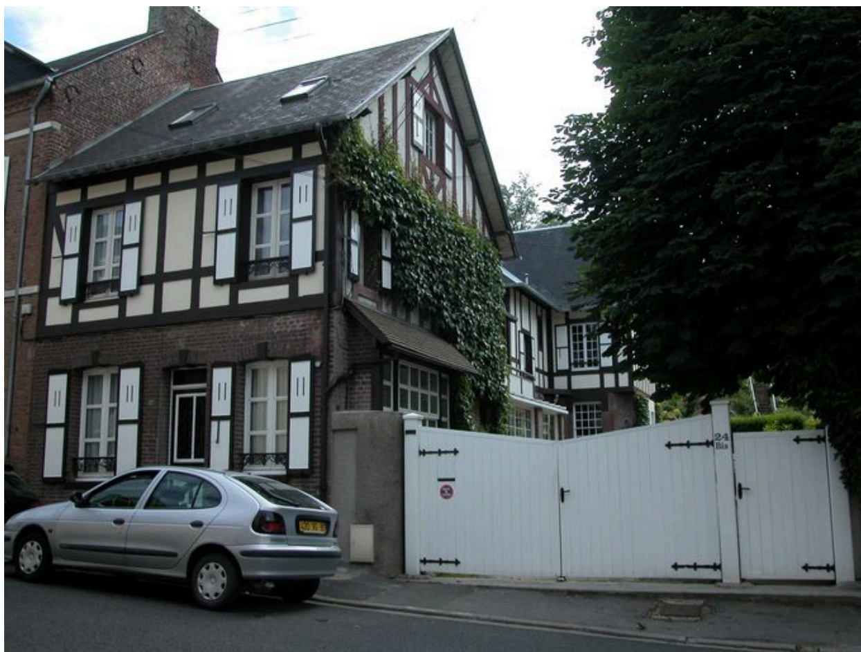
Maison, 24 bis avenue du Général-Leclerc (1983 AD 152).
