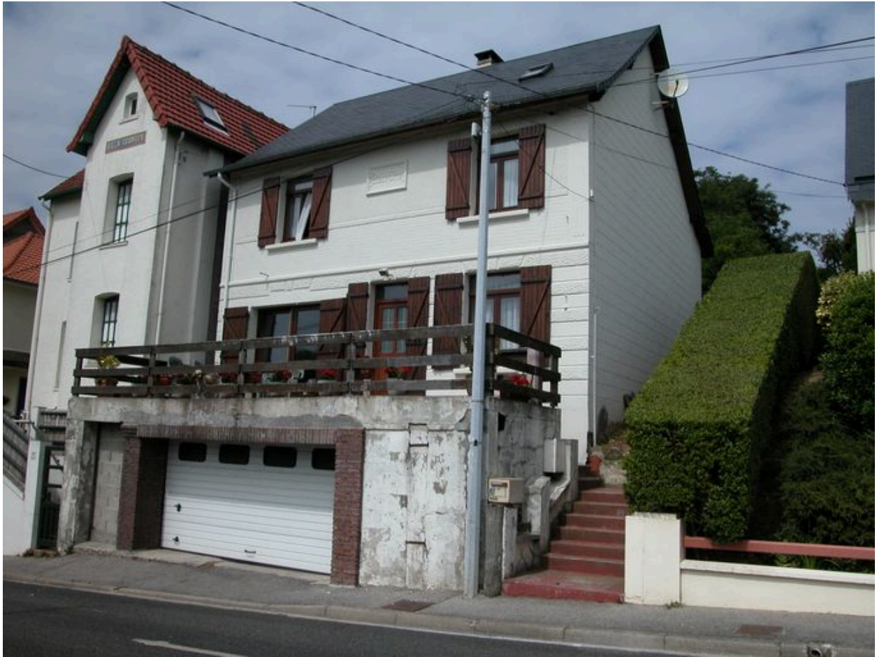
Maison dite Beau Site, 83 avenue du Général-Leclerc (1983 AD 190).
