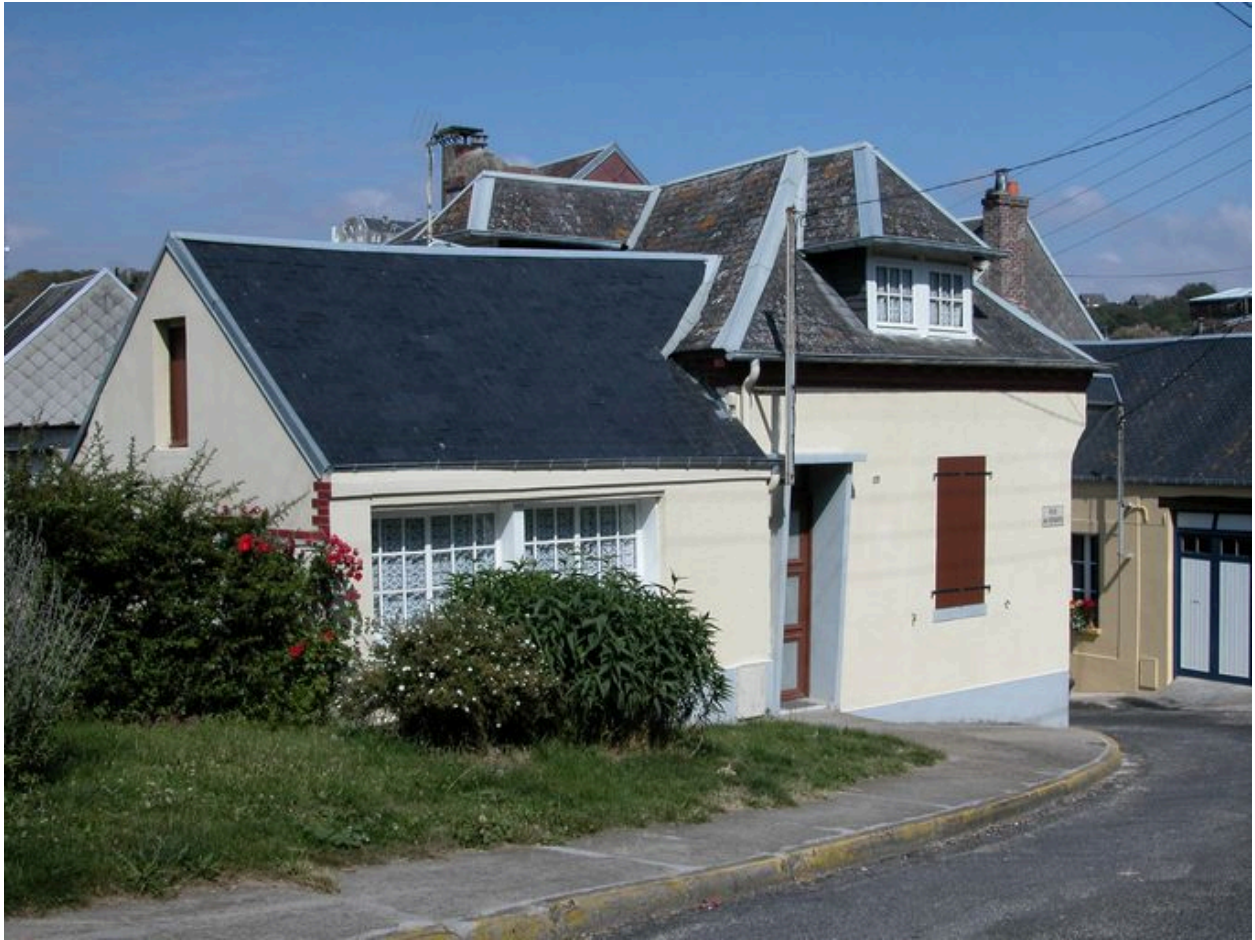
Ancienne maison de serrurier, quartier de Quinquerue.
