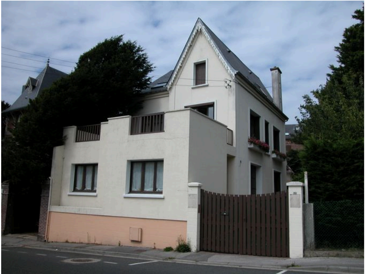
Maison, 29 avenue du Général-Leclerc (1983 AD 235).
