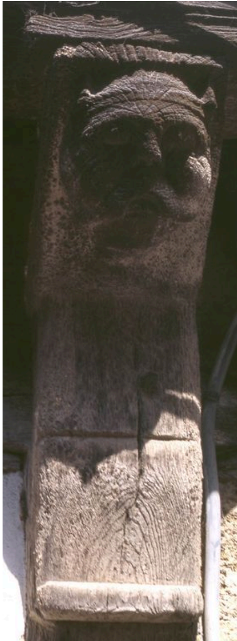
Détail d'une console sculptée, maison Landot, élévation postérieure sur cour.
