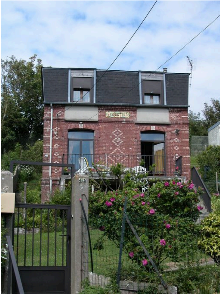
Maison dite Riquette, 39 rue Saint-Pierre (1983 AC 616).
