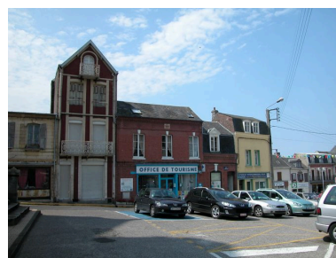
Maisons, place du Maréchal-Foch. Phot. Elisabeth Justome IVR22_20058003377NUCA
