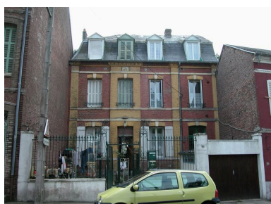
Maison portant la date '1864', 36 avenue du Général- Leclerc (1983 AD 168). Phot. Elisabeth Justome IVR22_20058003421NUCA
