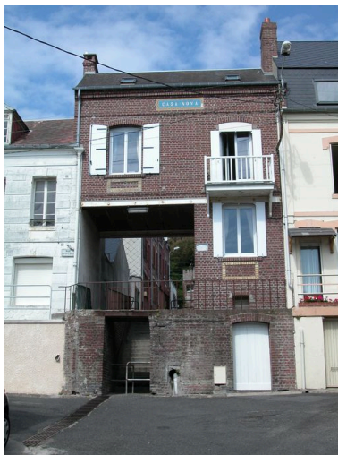
Casa Nova, rue des Fonts- Bénis, percée pour accéder à la ruelle Saint-Pierre. Phot. Elisabeth Justome IVR22_20058003425NUCA
