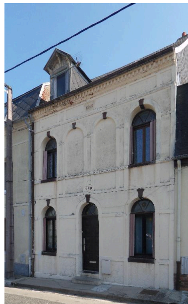
Maison, rue des Fonts-Bénis, datée 1862. Phot. Isabelle Barbedor IVR22_20158006719NUCA
