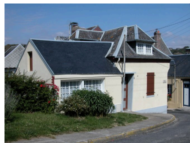
Ancienne maison de serrurier, quartier de Quinquerie. Phot. Elisabeth Justome IVR22_20058003048NUCA
