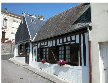
Maison ancienne avec pans de bois apparents, 12 ruelle de la Grande-Rue. Phot. Elisabeth Justome IVR22_20058003428NUCA
