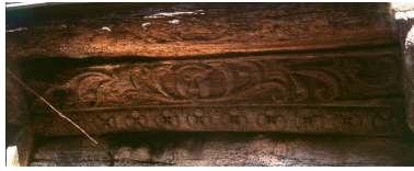
Détail d'une poutre sculptée de la maison Landot, élévation postérieure sur cour. Phot. Marie-Laure Monnehay-Vulliet IVR22_20058001157XA
