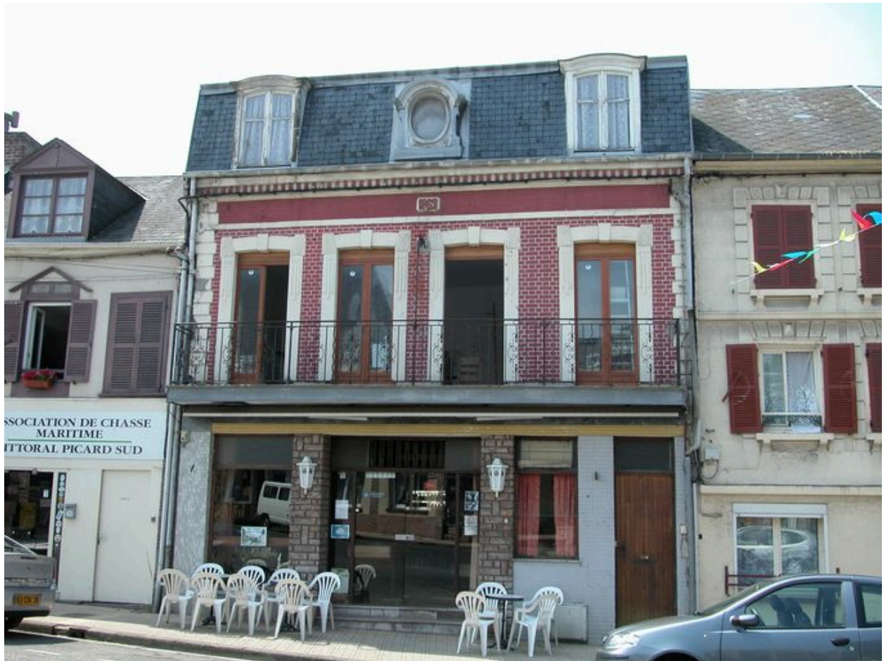
Maison, 36 Grande-Rue, portant la date 1862, deviendra le Café du Commerce.
