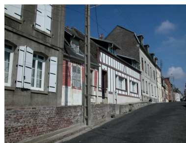
La rue des Fonts-Bénis, au niveau du numéro 21. Phot. Elisabeth Justome IVR22_20058003427NUCA
