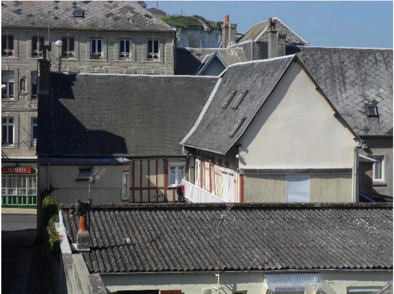
Maison, 7 Grande-rue, façade postérieure.
