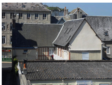
Maison, 7 Grande- rue, façade postérieure. Phot. Isabelle Barbedor IVR22_20158006726NUCA
