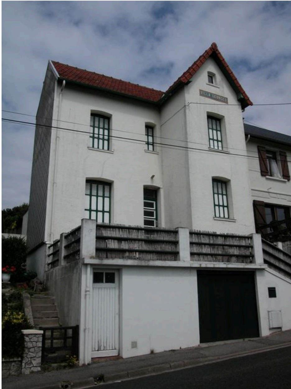
Villa Georges, 81 avenue du Général-Leclerc (1983 AD 191).
