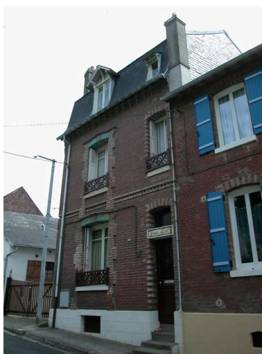
Maison dite Jan Pol, 10 rue Saint-Pierre (1983 AD 247). Phot. Elisabeth Justome IVR22_20058003423NUCA
