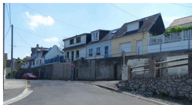
Quartier de Quinquerue. Le balcon de la rue des Bessaints. Phot. Isabelle Barbedor IVR22_20158006706NUCA
