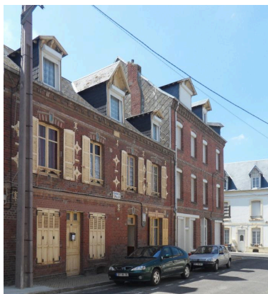
Maison, rue du Hamel, dite Raymond et Madeleine. Phot. Isabelle Barbedor IVR22_20158006710NUCA
