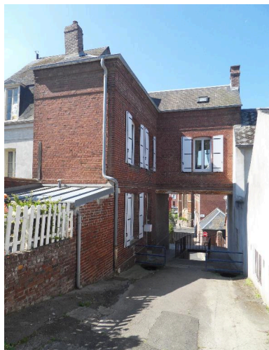
La ruelle Saint-Pierre et la villa Casa Nova. Phot. Isabelle Barbedor IVR22_20158006727NUCA
