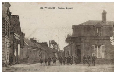
Ribeaucourt. Route de Domart (coll. part.). Le logis sur rue apparaît (à gauche) sur cette carte postale du début du 20e siècle. Phot. Monnehay-Vulliet Marie-Laure IVR22_20118000638NUCA
