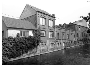
Vue latérale sud de l'usine. Phot. Laurent Jumel IVR22_19966002693X
