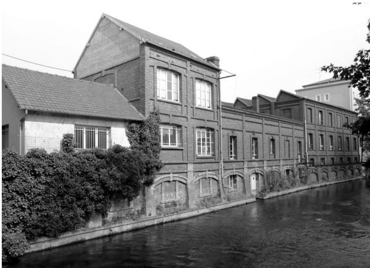
Vue latérale sud de l'usine.
