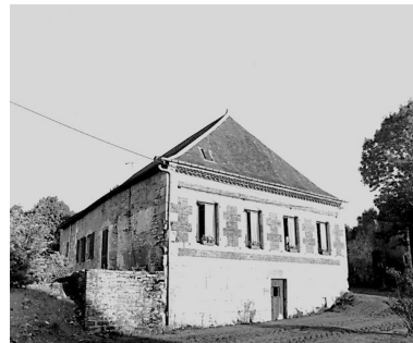
Élévation ouest et postérieure du logis. Phot. Xavier-Philippe Guiochon IVR22_19980202710Z
