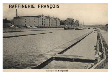
Les anciens entrepôts de sucres indigènes des Magasins généraux. Carte postale, début 20e siècle (coll. part.). Phot. Isabelle Barbedor IVR32_20210205175NUCA
