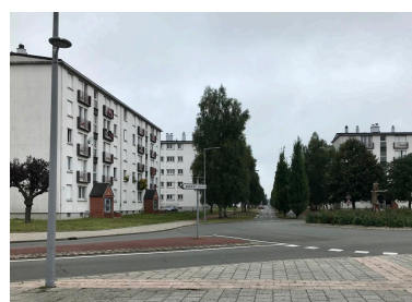
Vue de situation depuis le rond-point de la gare. Phot. Isabelle Barbedor IVR32_20210205176NUCA
