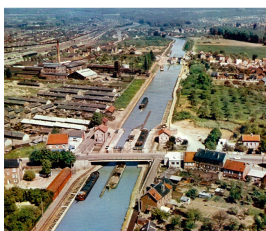
Vue aérienne du canal et de la cité provisoire. Carte postale, vers 1960 (coll. part.). Phot. Isabelle Barbedor IVR32_20210205177NUCA
