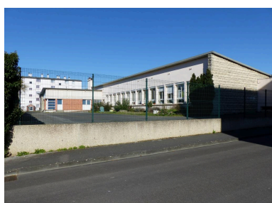
L'école primaire Roosevelt. Vue depuis la rue de la Résistance. Phot. Isabelle Barbedor IVR32_20220205025NUCA
