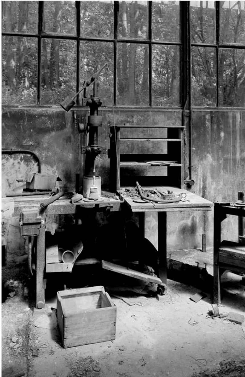
Atelier de fabrication reconstruit après la guerre, vue intérieure.
