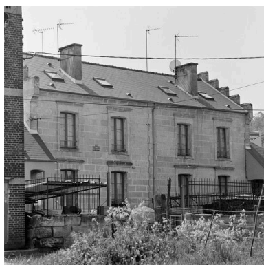
Logements d'ouvriers. Phot. Patrick Glotain IVR22_19936000573X
