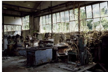
Atelier de fabrication : vue intérieure. Phot. Patrick Glotain IVR22_19936001829XA
