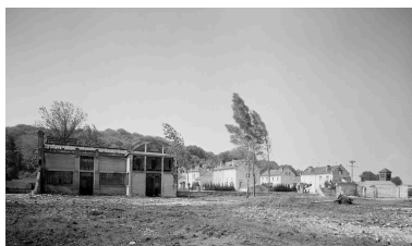
Atelier de fabrication de 1928 et logements d'ouvriers : vue générale sud. Phot. Patrick Glotain IVR22_19936000706V
