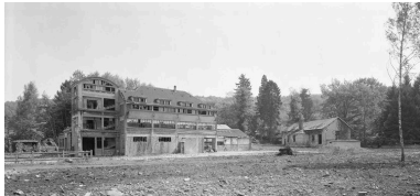
Atelier de fabrication modifié vers 1930 puis 1950 : façade sud. Phot. Patrick Glotain IVR22_19936000711V
