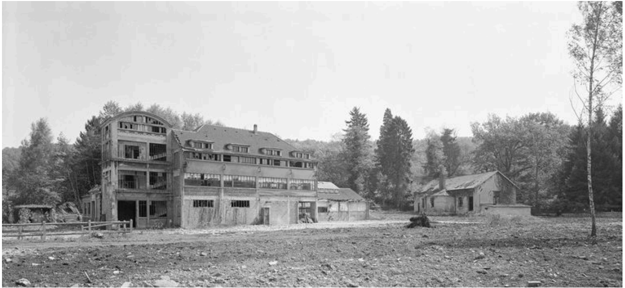
Atelier de fabrication modifié vers 1930 puis 1950 : façade sud.
