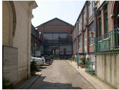
Vue de la cour intérieure. Phot. Isabelle Barbedor IVR22_20048010086NUCA
