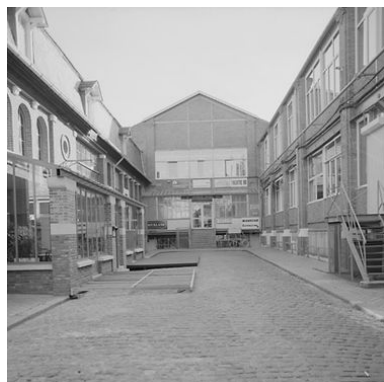
La cour intérieure en 1989. Phot. Thierry Lefébure IVR22_19898000451X
