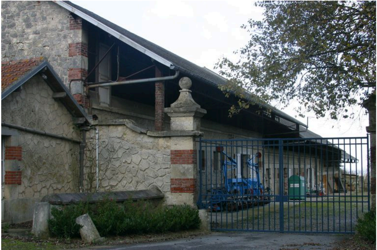
Vue de bâtiments agricoles situés sur le côté gauche de la propriété, surmontés de greniers à foin.
