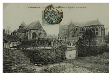
L'ancienne église, l'ancien cimetière et la nouvelle église Saint-Quentin en construction, vers 1905 (coll. part.). Repro. Romain Grimaud IVR22_20128005196NUC2A
