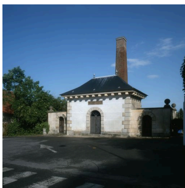
Façade antérieure. Phot. Thierry Lefébure IVR22_20006000637XA
