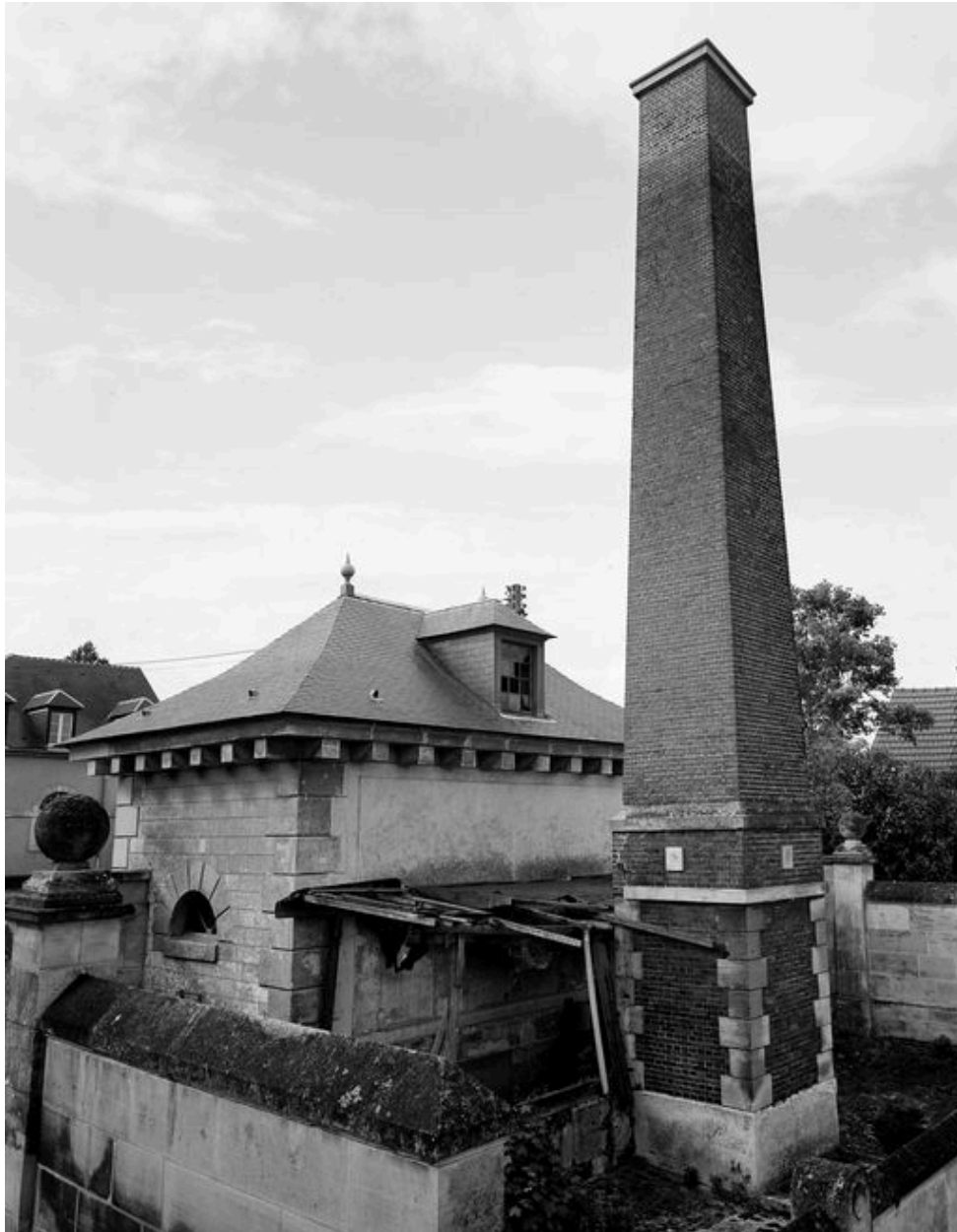
Façade postérieure : vue d'ensemble avec le bâtiment des chaudières et la cheminée.
