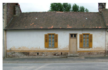
Façade du logis sur rue. Phot. Frédéric Fournis IVR22_20098005042NUCA
