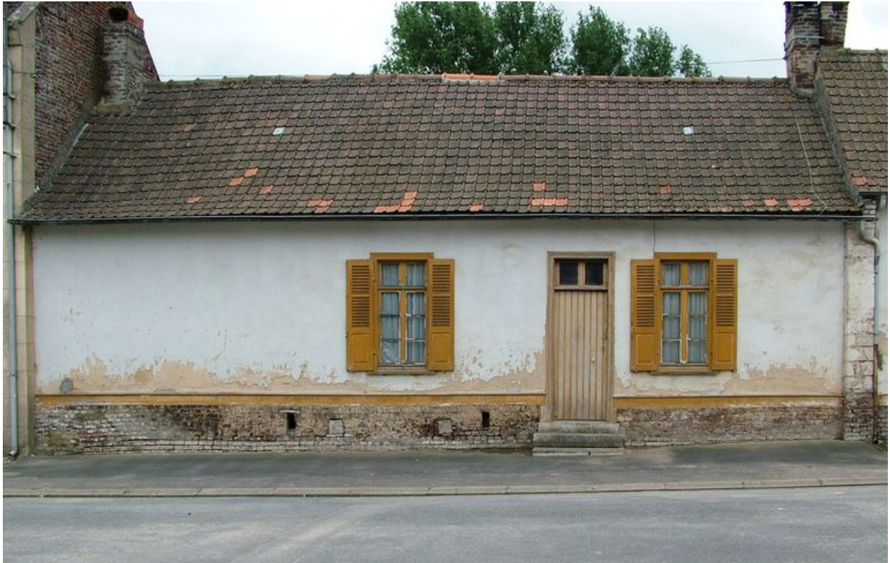
Façade du logis sur rue.
