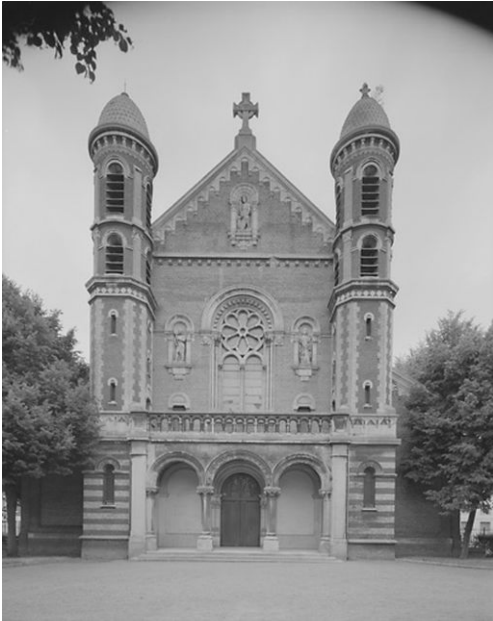
Vue de la façade ouest (liturgique).
