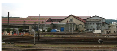
Les ateliers Daydé depuis l'usine Fichet. Phot. Clarisse Lorieux IVR22_20076005016NUCA
