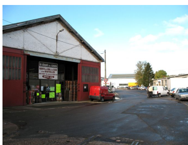
Ancien garage à l'entrée du parc à matériel. Phot. Clarisse Lorieux IVR22_20066005146NUCA
