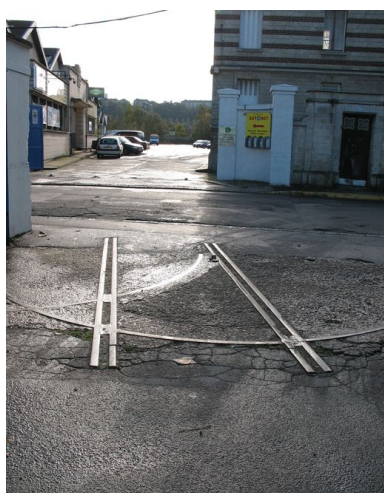
Arrivée de l'embranchement ferroviaire dans la cour de stockage du matériel. Phot. Clarisse Lorieux IVR22_20066005145NUCA
