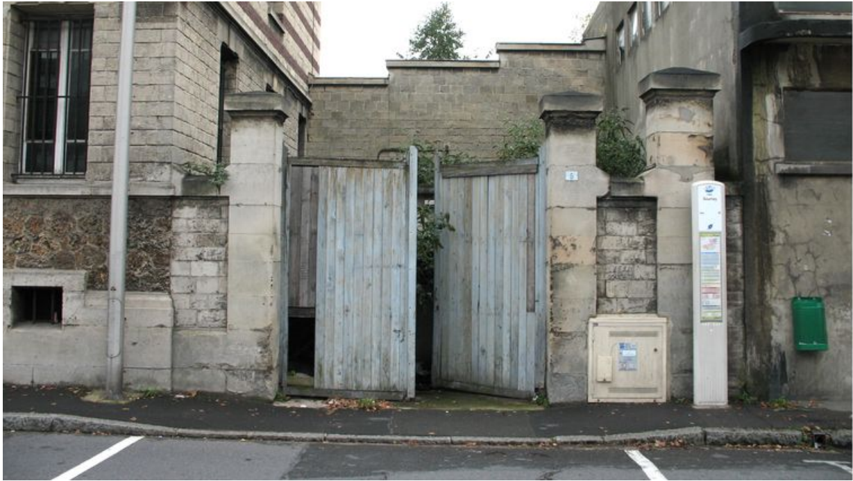
Portail d'entrée des bureaux.
