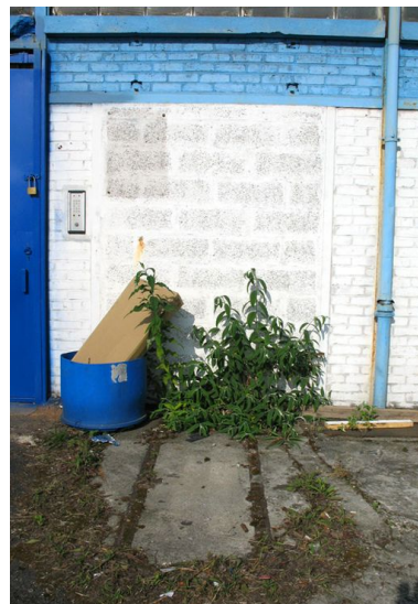
Voie Decauville desservant le magasin aux peintures et aux huiles. Phot. Clarisse Lorieux IVR22_20076005381NUCA
