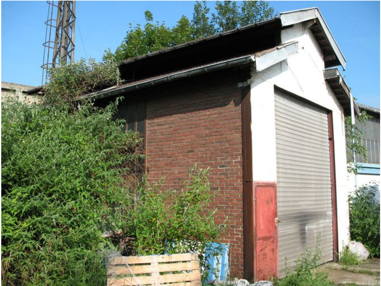
Remise à locomotives.
