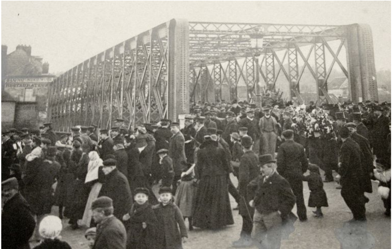
Le pont de Creil avant 1914 construit par l'usine Daydé-Pillé, Merlette (photographe) (AC Creil).
