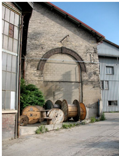
Vue partielle de l'atelier des ponts et charpentes. Phot. Clarisse Lorieux IVR22_20076005371NUCA
