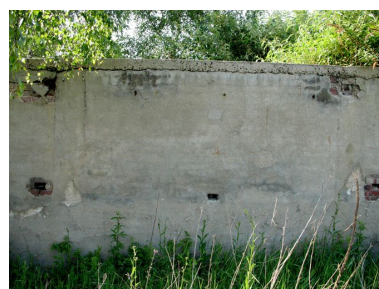
Mur de clôture de l'usine en brique enduite. Phot. Clarisse Lorieux IVR22_20076005384NUCA
