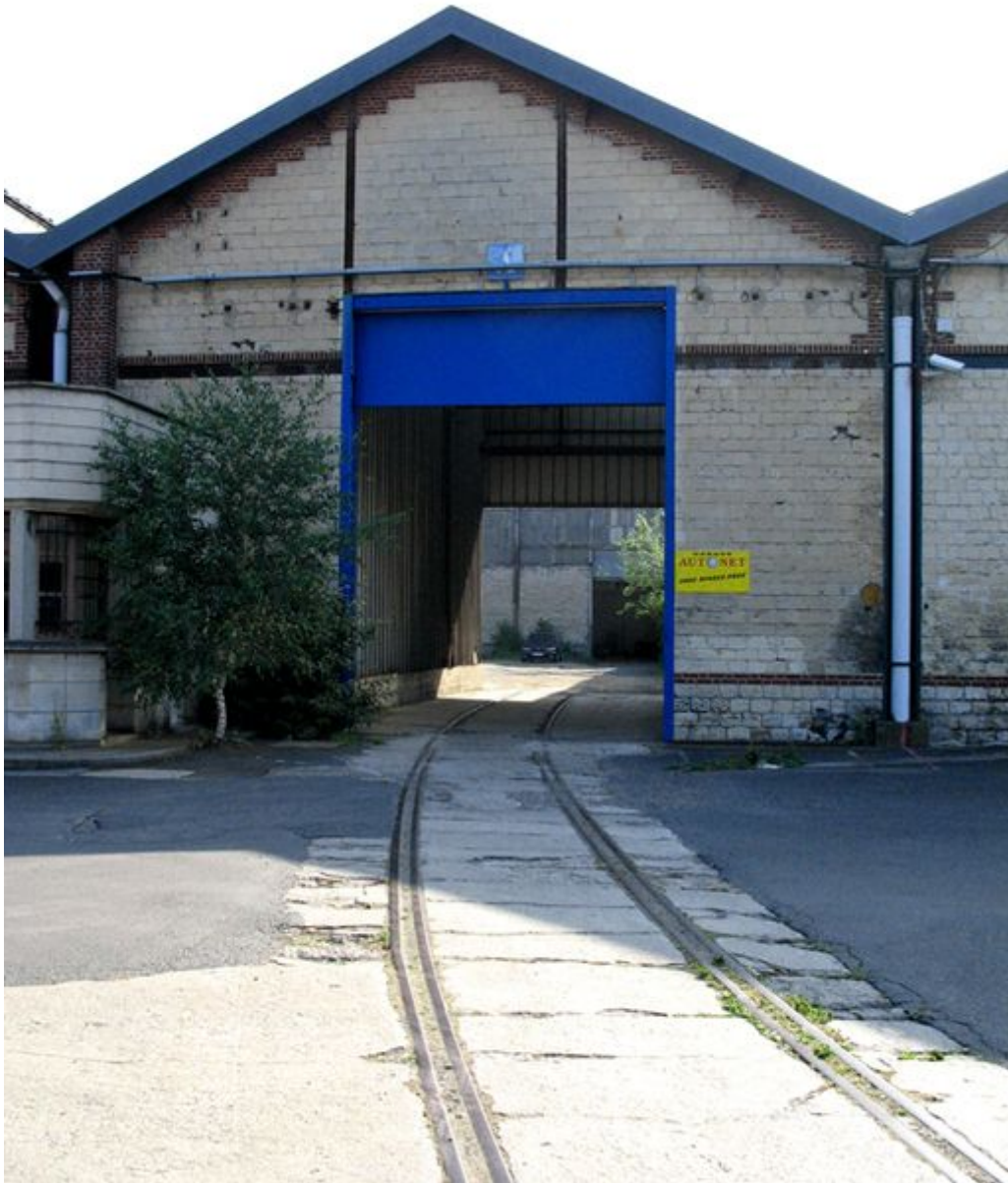
Rails partant vers la grande halle de montage.
