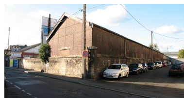
Anciens bâtiments de stockage. Phot. Clarisse Lorieux IVR22_20066005141NUCA
