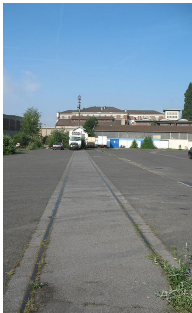
Rails desservant la remise à locomotive. Phot. Clarisse Lorieux IVR22_20076005379NUCA
