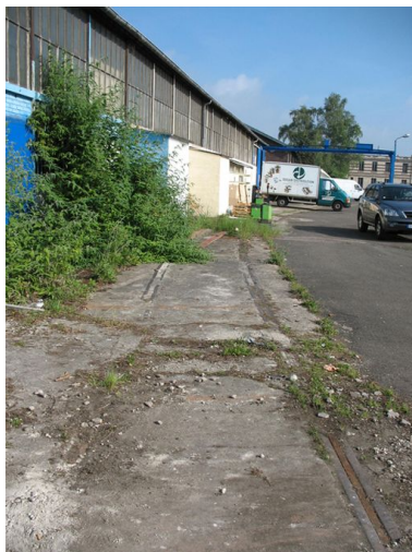
Rails le long des magasins industriels. Phot. Clarisse Lorieux IVR22_20076005380NUCA
