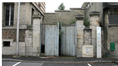
Portail d'entrée des bureaux. Phot. Clarisse Lorieux IVR22_20066005153NUCA
