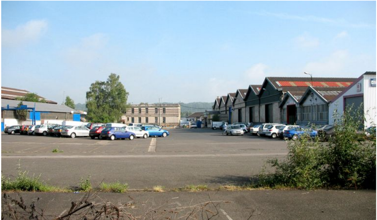
Vue générale des établissements Daydé : à gauche, les magasins industriels, au fond les bureaux et l'infirmerie, à droite les ateliers de fabrication.
