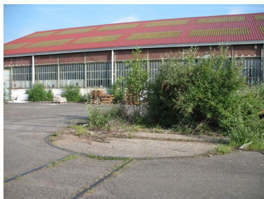
Rails du pont tournant et à l'arrière-plan atelier de mécanique et d'ajustage. Phot. Clarisse Lorieux IVR22_20076005372NUCA
