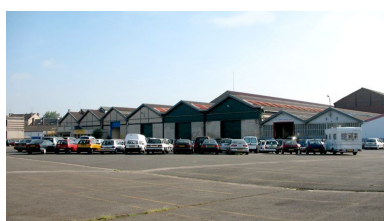
Les ateliers de fabrication. Phot. Clarisse Lorieux IVR22_20076005368NUCA
