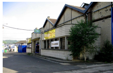
Bureau de pointage et douches. Phot. Clarisse Lorieux IVR22_20076005376NUCA
