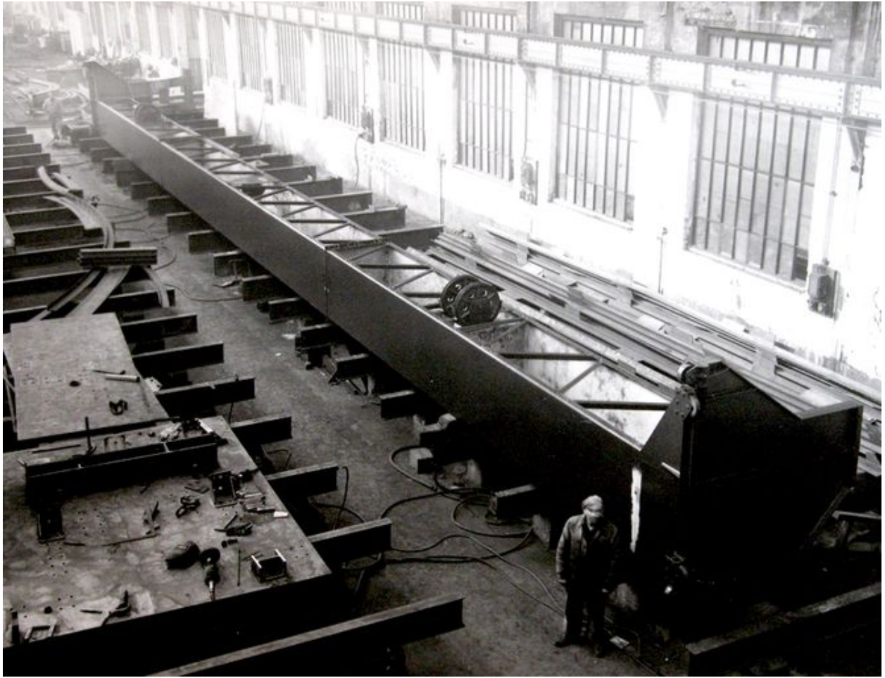
Batardeaux, chute de Baix (Ardèche), 1961 (collection particulière).
