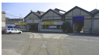
Double voie partant à droite vers la halle de montage et à gauche vers le parc à matériel. Phot. Clarisse Lorieux IVR22_20076005382NUCA
