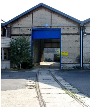
Rails partant vers la grande halle de montage. Phot. Clarisse Lorieux IVR22_20076005383NUCA
