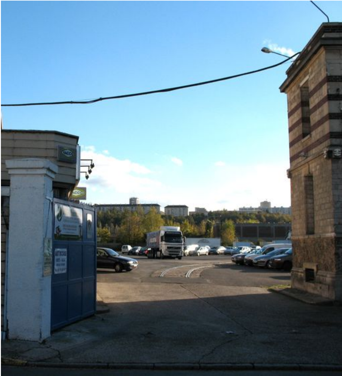
Cour de l'ancienne usine Daydé et son embranchement ferroviaire.
