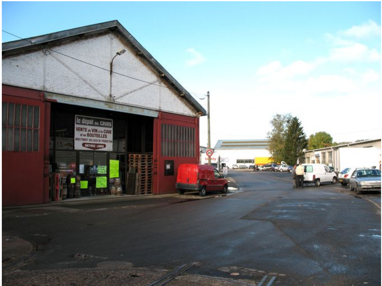
Ancien garage à l'entrée du parc à matériel.
