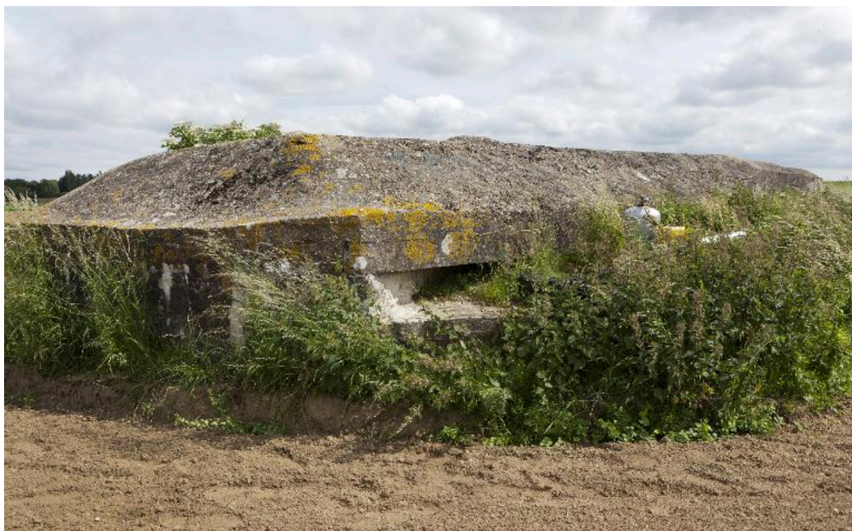
Créneau de fusillade, vers le sud
