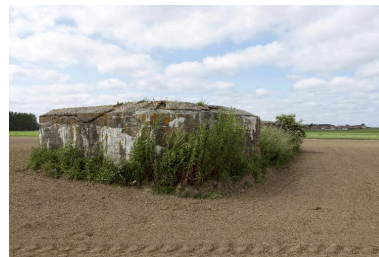
Vue vers le nord. Phot. Jean-Marc Ramette IVR31_20145904817NUCA
