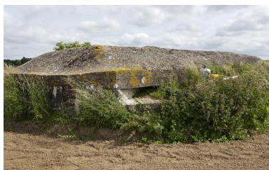
Créneau de fusillade, vers le sud Phot. Jean-Marc Ramette IVR31_20145904818NUCA
