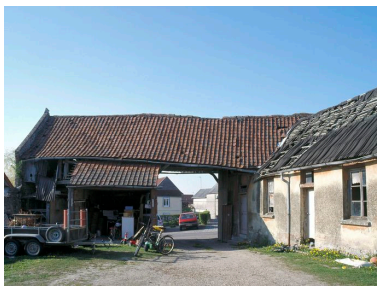
Grange, passage charretier et ancienne étable sur la cour. Phot. Marie-Laure Monnehay-Vulliet IVR22_20108000146XA
