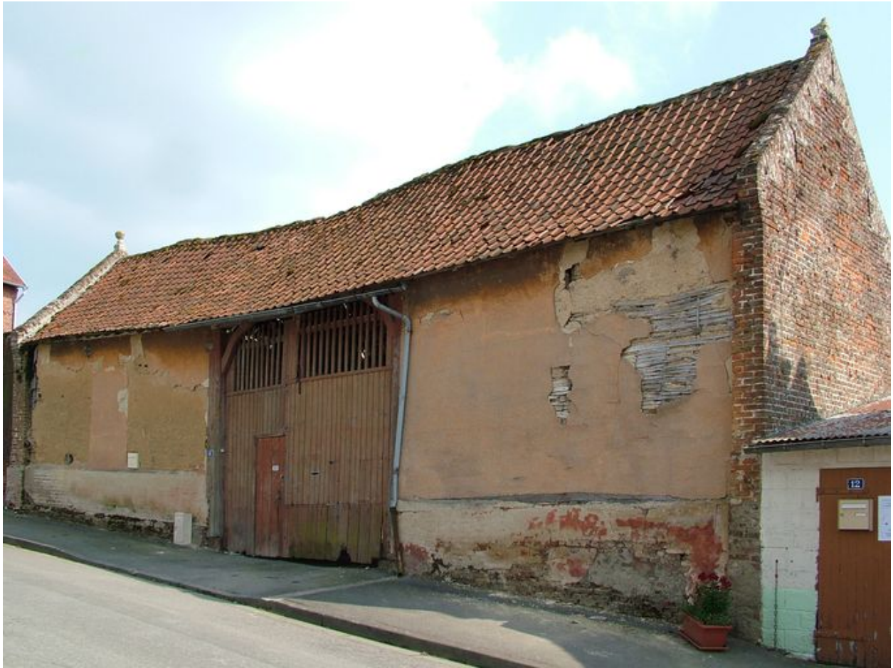
Grange et passage charretier sur rue.
