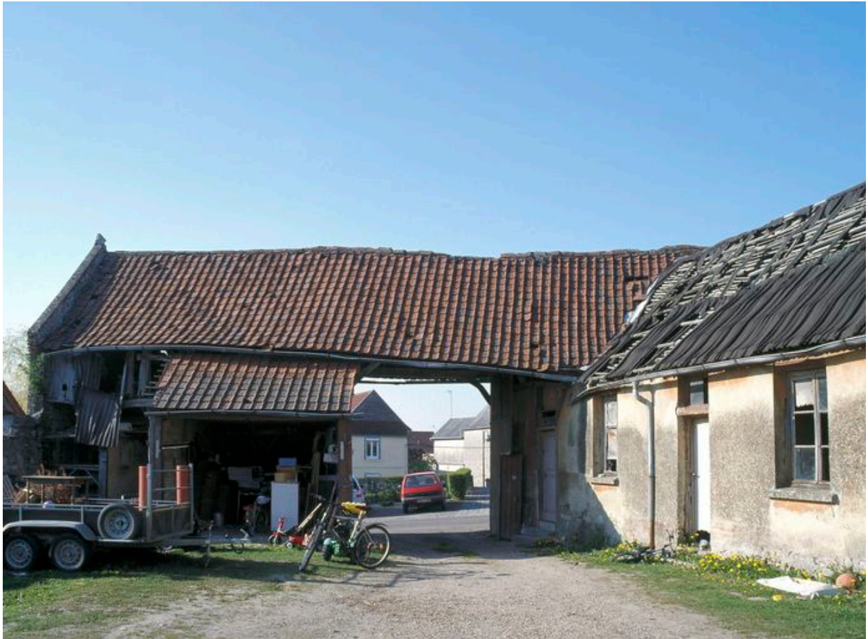
Grange, passage charretier et ancienne étable sur la cour.
