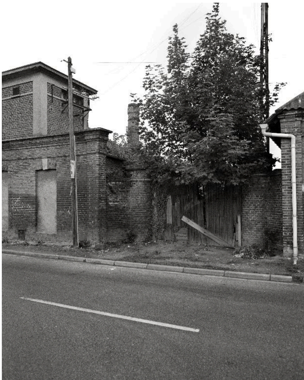
Vue depuis la rue Joliot-Curie (ancienne rue de Woincourt), en 1988 : ancien accès et cheminée d'usine à l'arrière-plan détruits).
