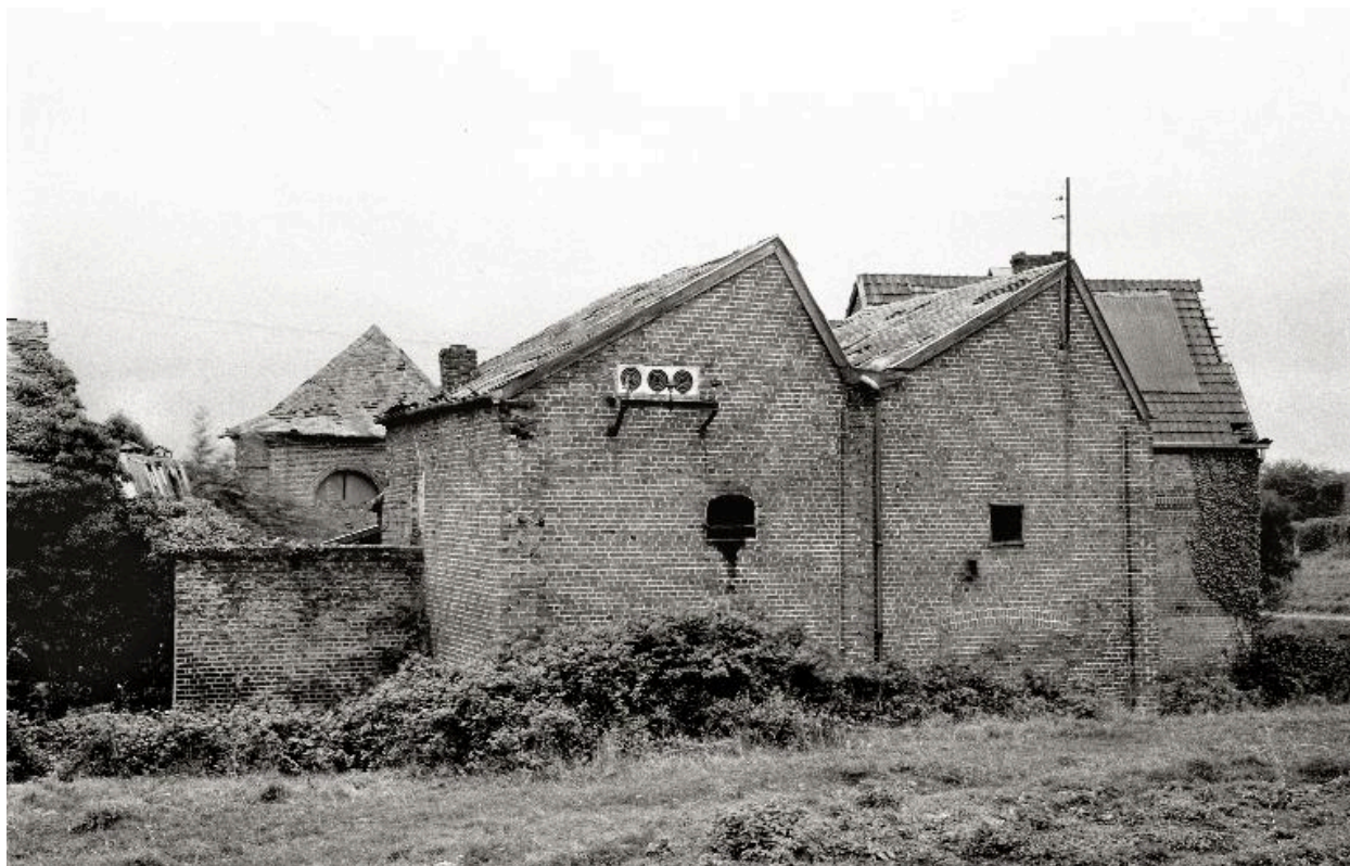
Vue depuis l'est, en 1988 : Ancien moteur à gaz, puis transformateur haute tension (détruit), en 1988.
