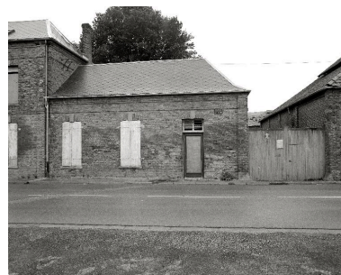
Vue depuis la rue Joliot-Curie (ancienne rue de Woincourt), en 1988 : ancien bureau des vérifications. Phot. Thierry Lefébure IVR22_19888001041X
