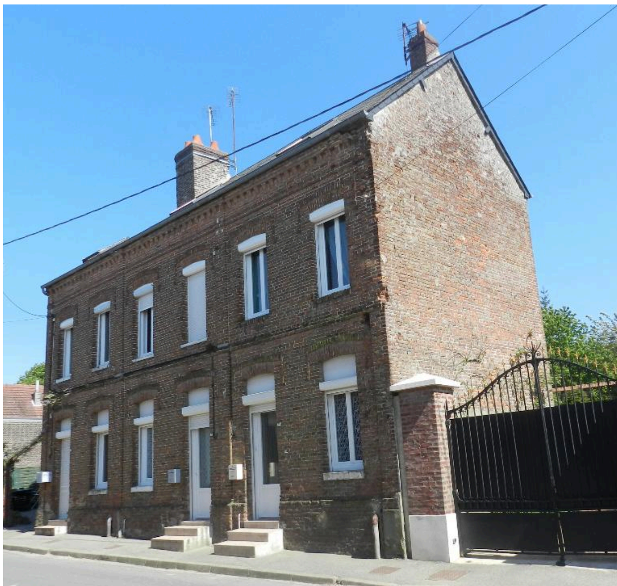
Ensemble de trois logements de contremaître, 13 à 17 rue Joliot-Curie, construits pour Frenkl, en 1872.
