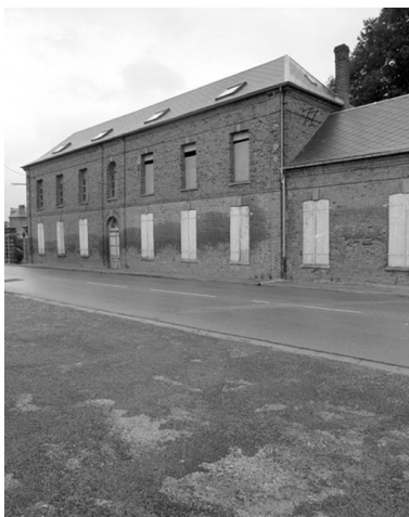
Vue depuis la rue Joliot-Curie (ancienne rue de Woincourt), en 1988 : anciens bureaux. Phot. Thierry Lefébure IVR22_19888001040X
