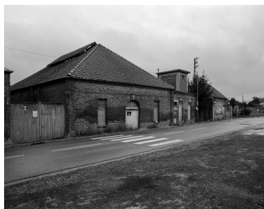
Vue depuis la rue Joliot-Curie (ancienne rue de Woincourt), en 1988 : ancien atelier (détruit). Phot. Thierry Lefébure IVR22_19888001042X
