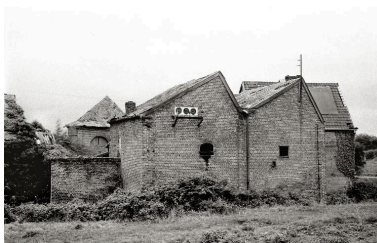
Vue depuis l'est, en 1988 : Ancien moteur à gaz, puis transformateur haute tension (détruit), en 1988. Phot. Thierry Lefébure IVR22_19888001070V
