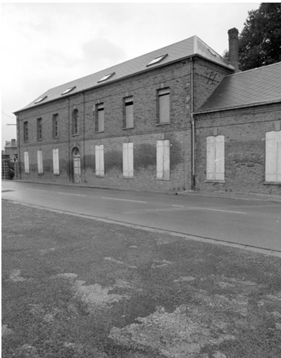
Vue depuis la rue Joliot-Curie (ancienne rue de Woincourt), en 1988 : anciens bureaux.
