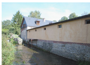
Vue d'ensemble du moulin et du mur de clôture attenant donnant sur la rivière. Phot. Bertrand Fournier IVR22_20046002960NUCA
