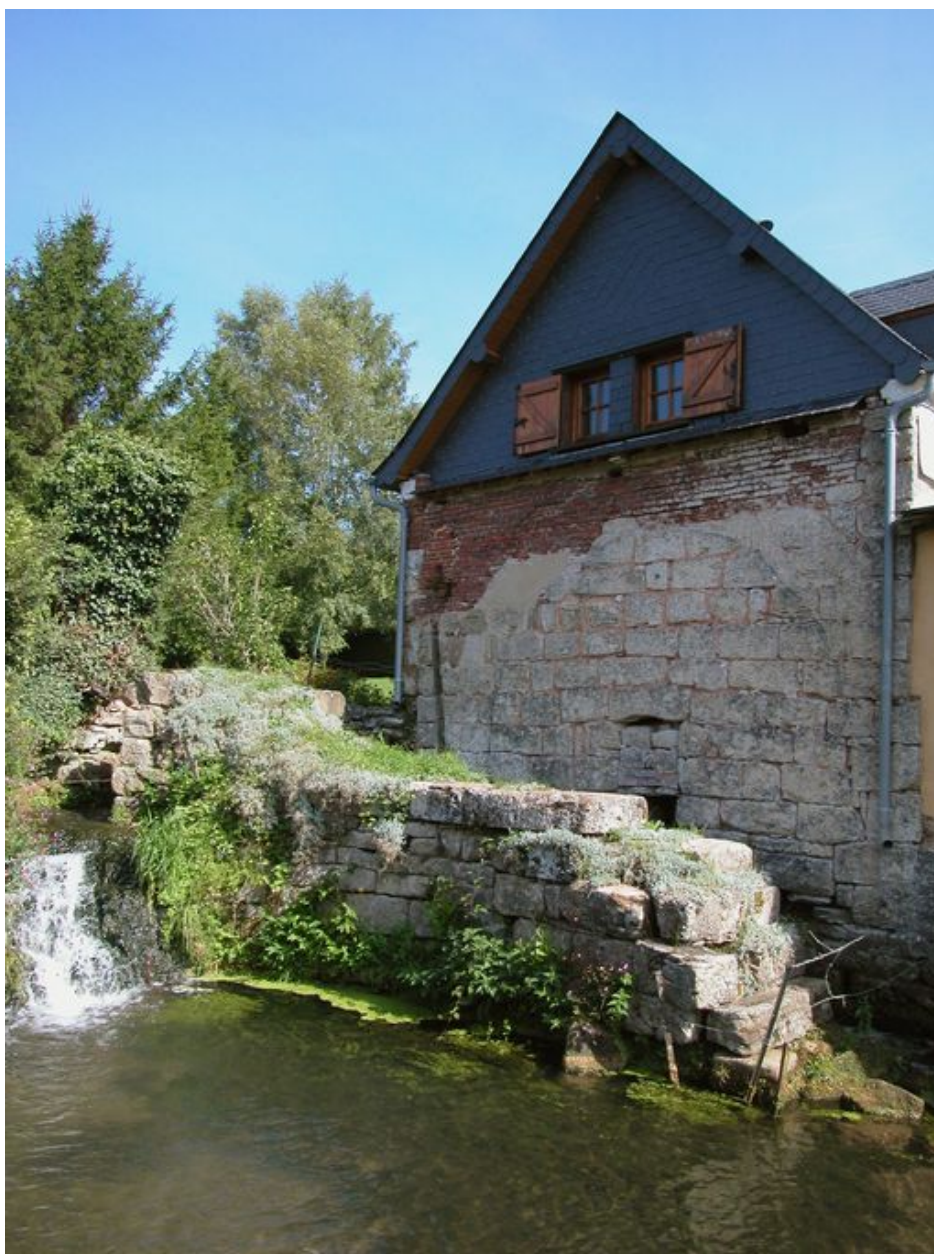
Détail du pignon du moulin hydraulique.
