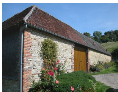
L'entrée charretière cantonnée des granges fermant la propriété à l'avant. Phot. Bertrand Fournier IVR22_20046002961NUCA
