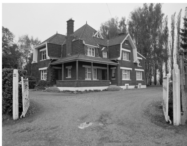
Vue générale de la villa patronale construite vers 1948-1949.
