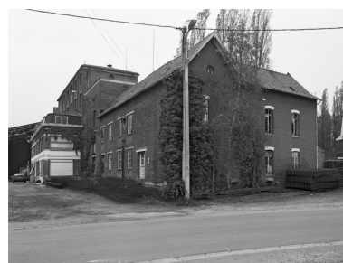
Vue de l'entrée du site depuis la rue, à droite, le premier bâtiment de 1924, à gauche le premier logis patronal construit vers 1925-1926. Phot. Philippe Dapvril IVR31_20085901103X
