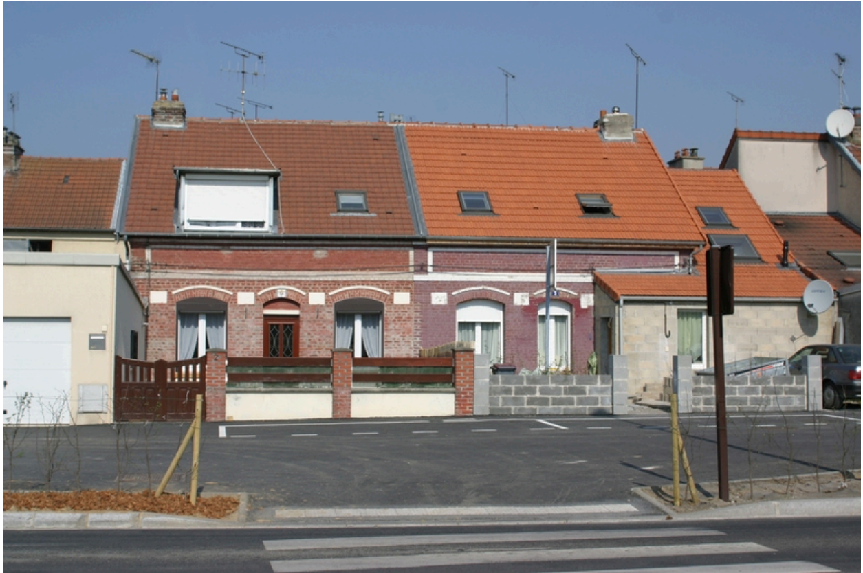
Façade d'un pavillon de la cité Dambrun.
