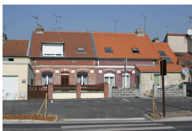
Façade d'un pavillon de la cité Dambrun.
