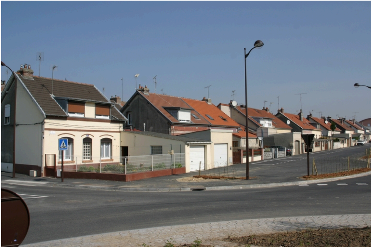
Logements ouvriers de la cité Dambrun des années 1900.
