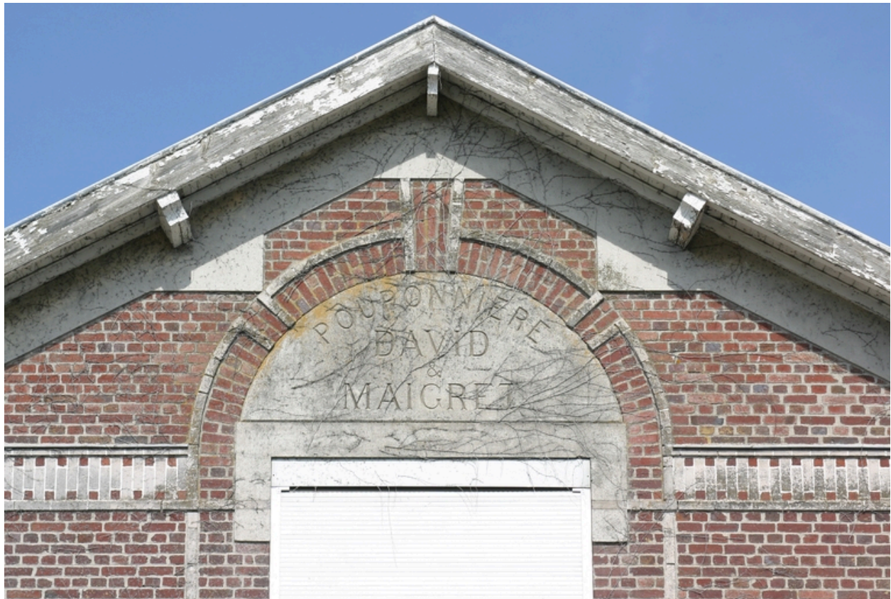
Détail de la façade antérieure de la pouponnière.
