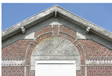
Détail de la façade antérieure de la pouponnière. Phot. Frédéric Pillet IVR22_20070205161NUCA
