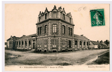
9. Villers-Bretonneux. Ecole de filles, carte postale début 20e siècle (coll. part. Drillancourt). Phot. Thierry Lefébure IVR32_20218000229NUCA
