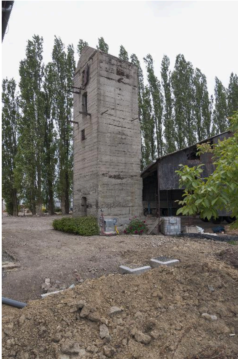
Vue de trois-quarts vers l'ouest de l'observatoire casematé (A). On note la présence de trois portes et d'une baie dotée d'une grille
