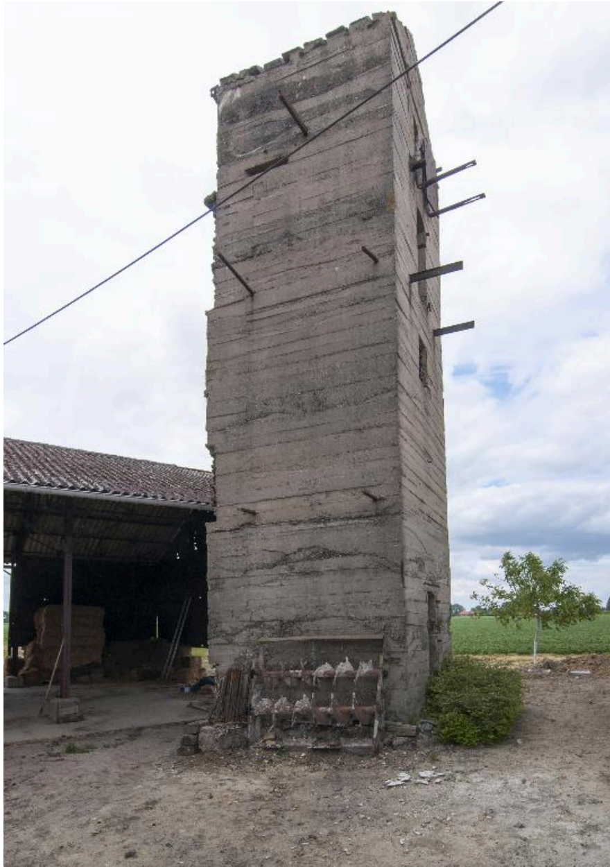
Vue de trois-quarts vers le nord-est de l'observatoire casematé (A). On note la présence d'une embrasure au sommet, orientée vers l'ouest
