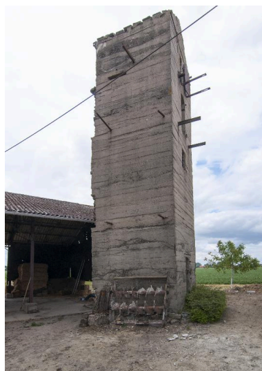
Vue de trois-quarts vers le nord-est de l'observatoire casematé (A). On note la présence d'une embrasure au sommet, orientée vers l'ouest Phot. Jean-Marc Ramette IVR32_20165901023NUCA
