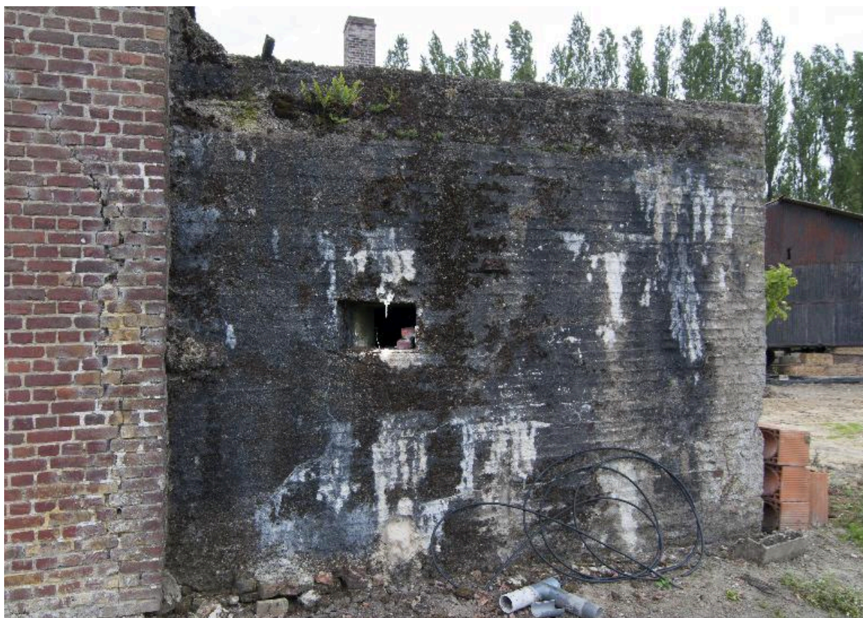
Casemate B, vers le sud-ouest
