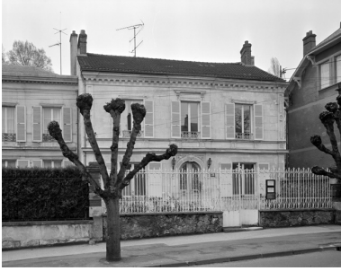
Vue générale depuis la rue. Phot. Thierry Lefébure IVR22_19940200319V
