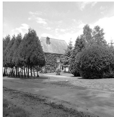
Vue générale. Phot. Thierry Lefébure IVR22_20020200446X
