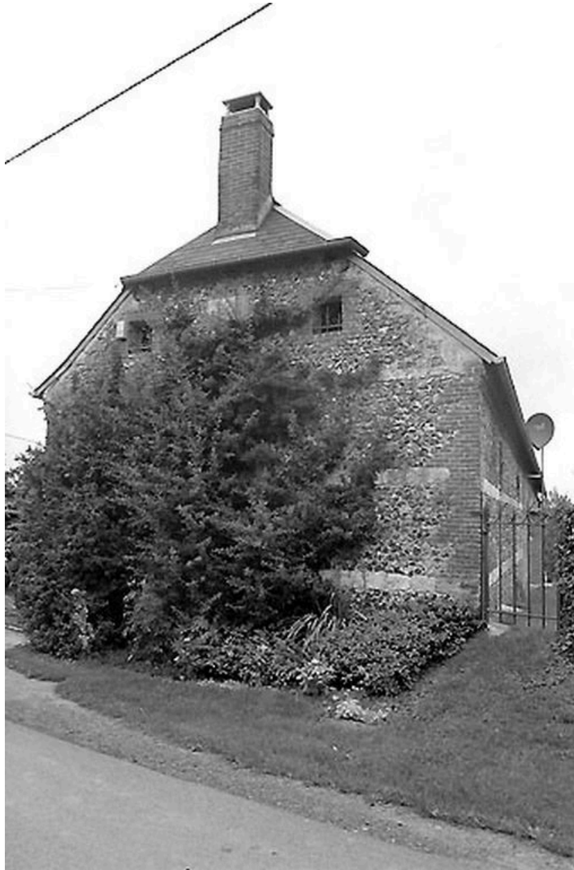
Vue générale du mur pignon du logis.
