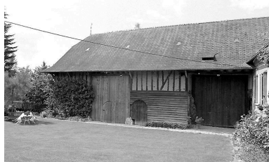
Grange traversante. Phot. Xavier-Philippe Guiochon IVR22_19980202343Z
