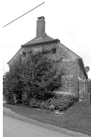
Vue générale du mur pignon du logis. Phot. Xavier-Philippe Guiochon IVR22_19980202342Z
