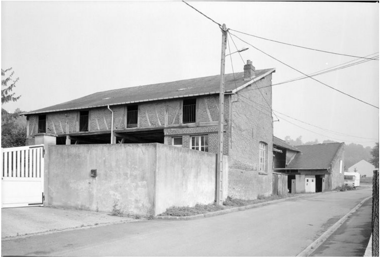
Ancien atelier de fabrication. Vue générale.
