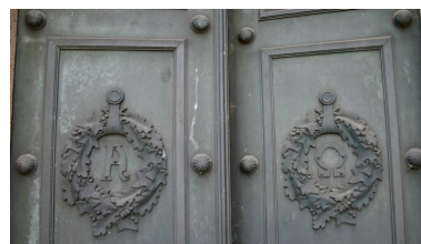
Détail du décor de la porte en fonte ouvragée : couronnes de feuilles de chêne et de lierre, entrelacées de rubans et ornées de l'alpha et de l'oméga. Phot. Caroline Vincent IVR22_20088000410NUCA
