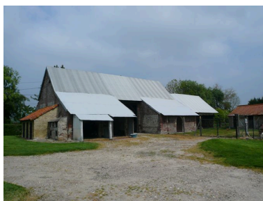
Vue de la grange depuis la cour. Phot. Inès Guérin IVR22_20078005810NUCA
