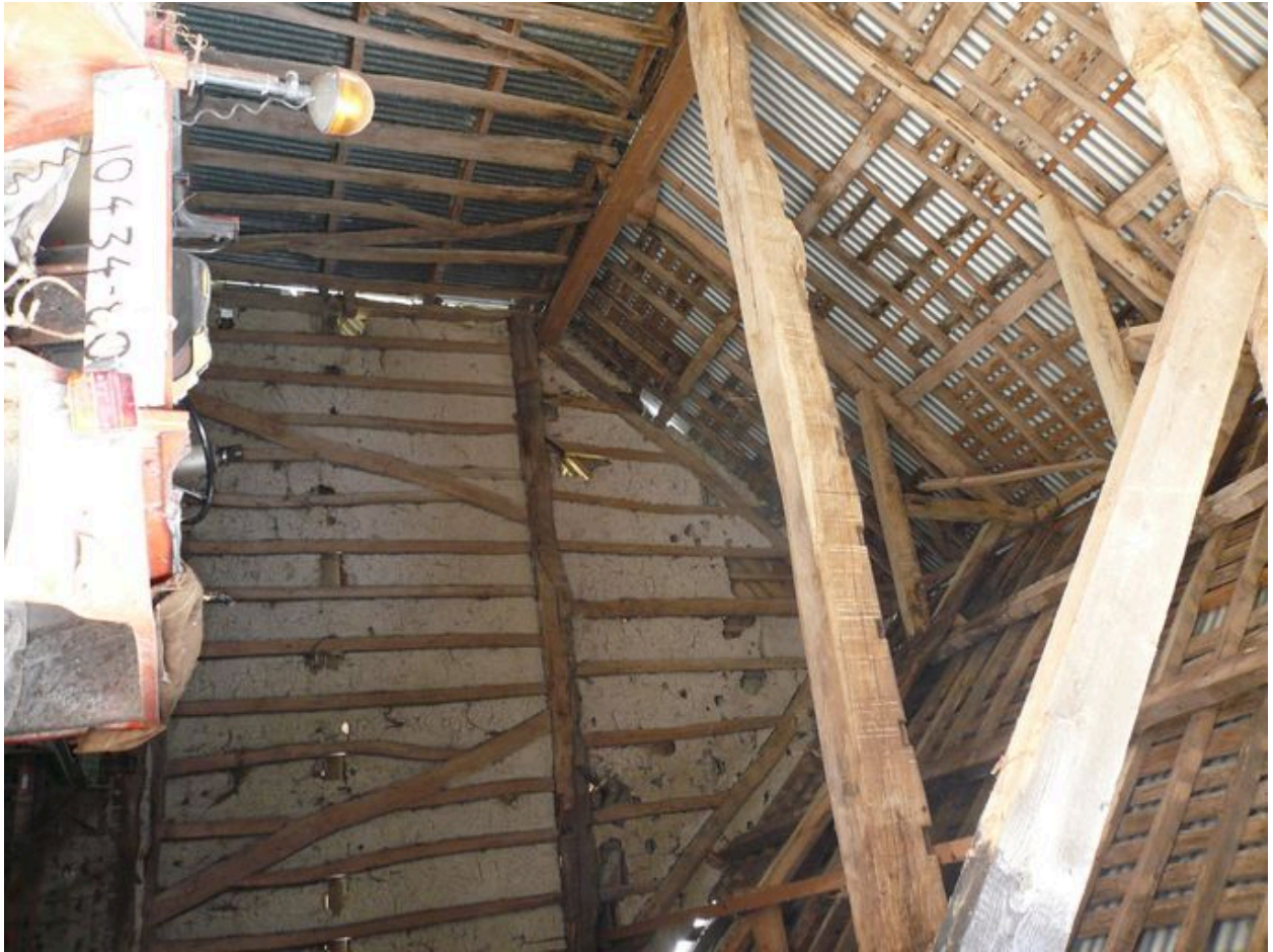
Vue intérieure de la grange.
