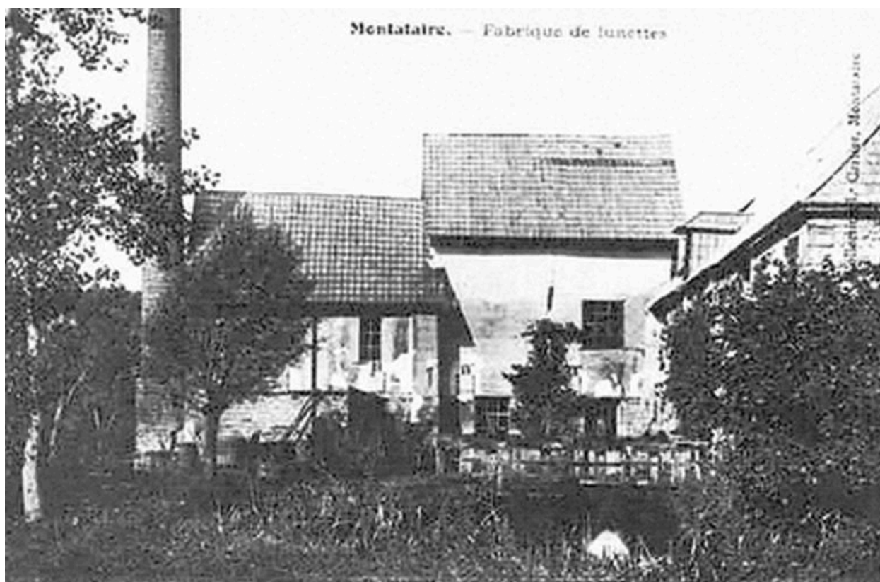
Usine I : usine de fabrication de verres d'optique établie sur le Thérain, début 20e siècle (AC Montataire).
