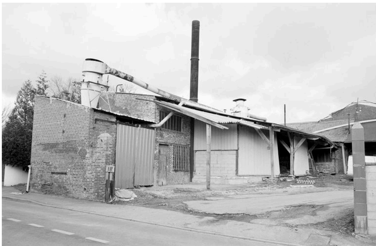
Chaufferie avec sa cheminée métallique.
