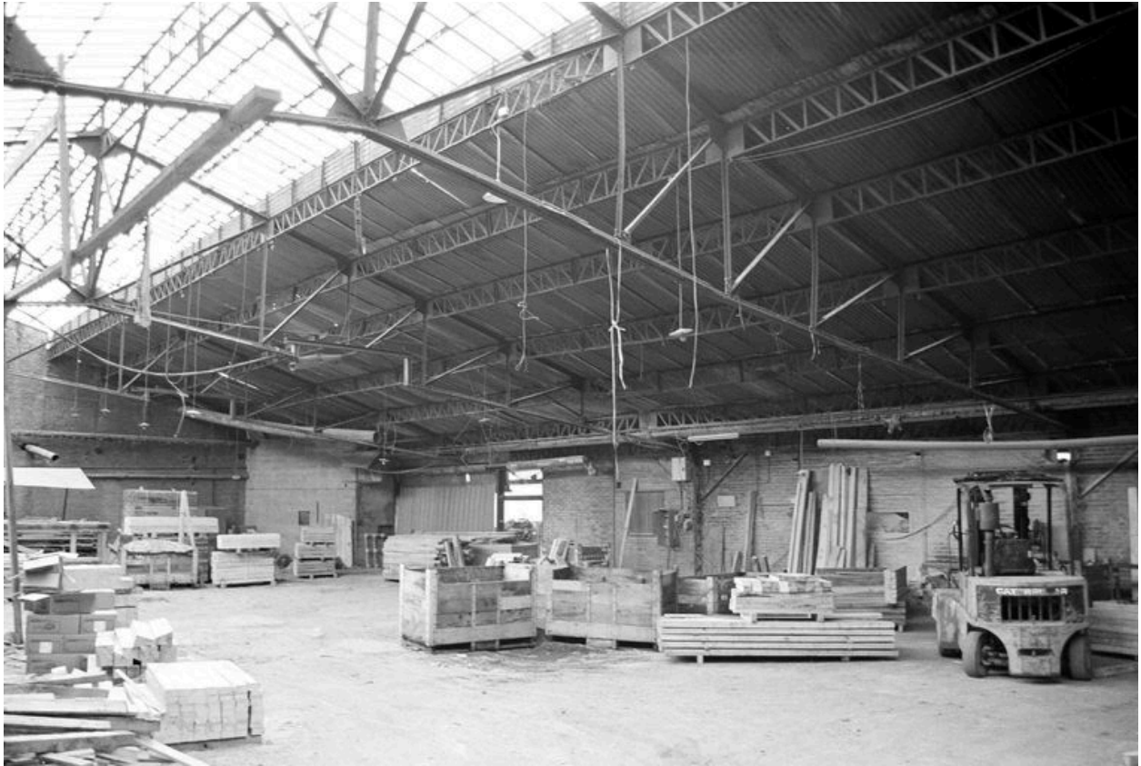
Vue intérieure de l'atelier de fabrication, avec sa charpente métallique apparente, reconstruit en 1913.
