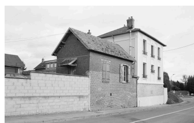
Réception et logement patronal : façade sur rue.
