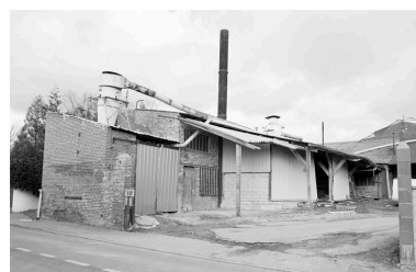
Chaufferie avec sa cheminée métallique.
