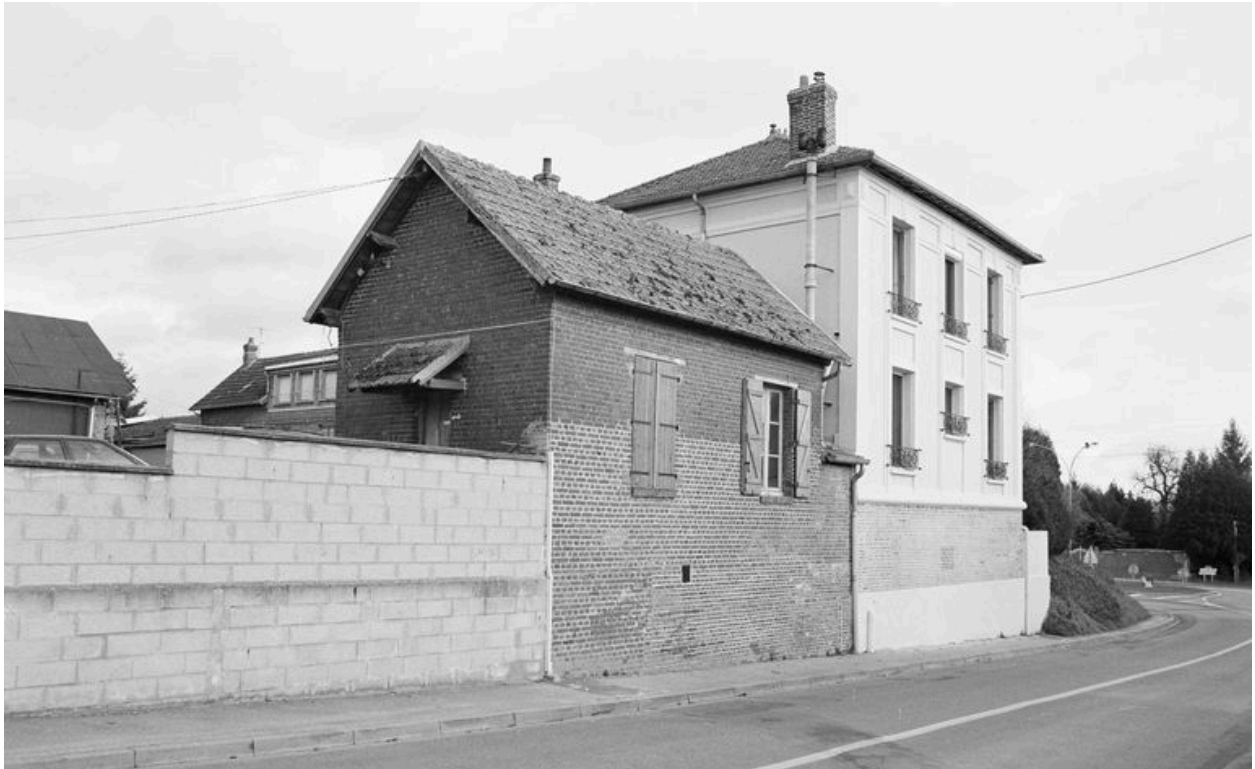
Réception et logement patronal : façade sur rue.
