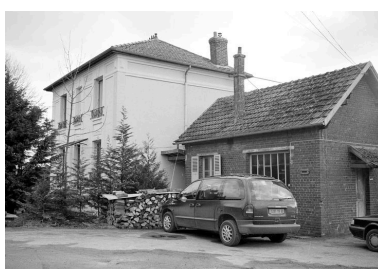
Réception et logement patronal : façade sur cour.
