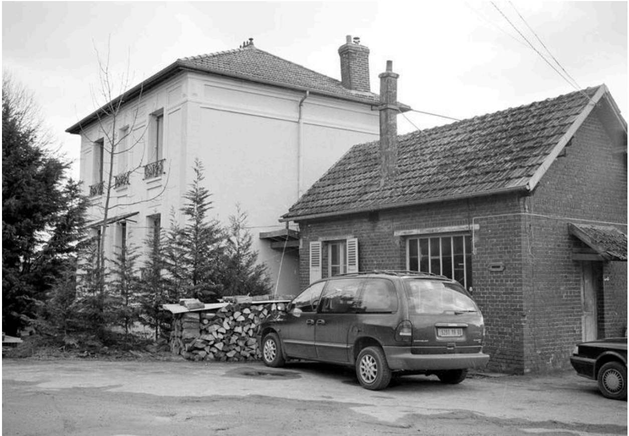
Réception et logement patronal : façade sur cour.
