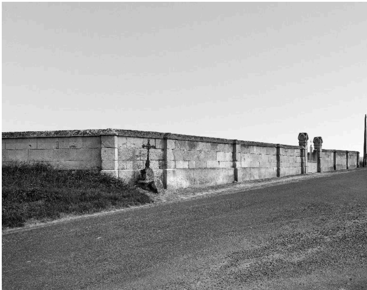
Vue de l'élévation sur rue du mur de clôture.
