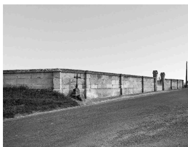
Vue de l'élévation sur rue du mur de clôture. Phot. Thierry Lefébure IVR22_19900200877V
