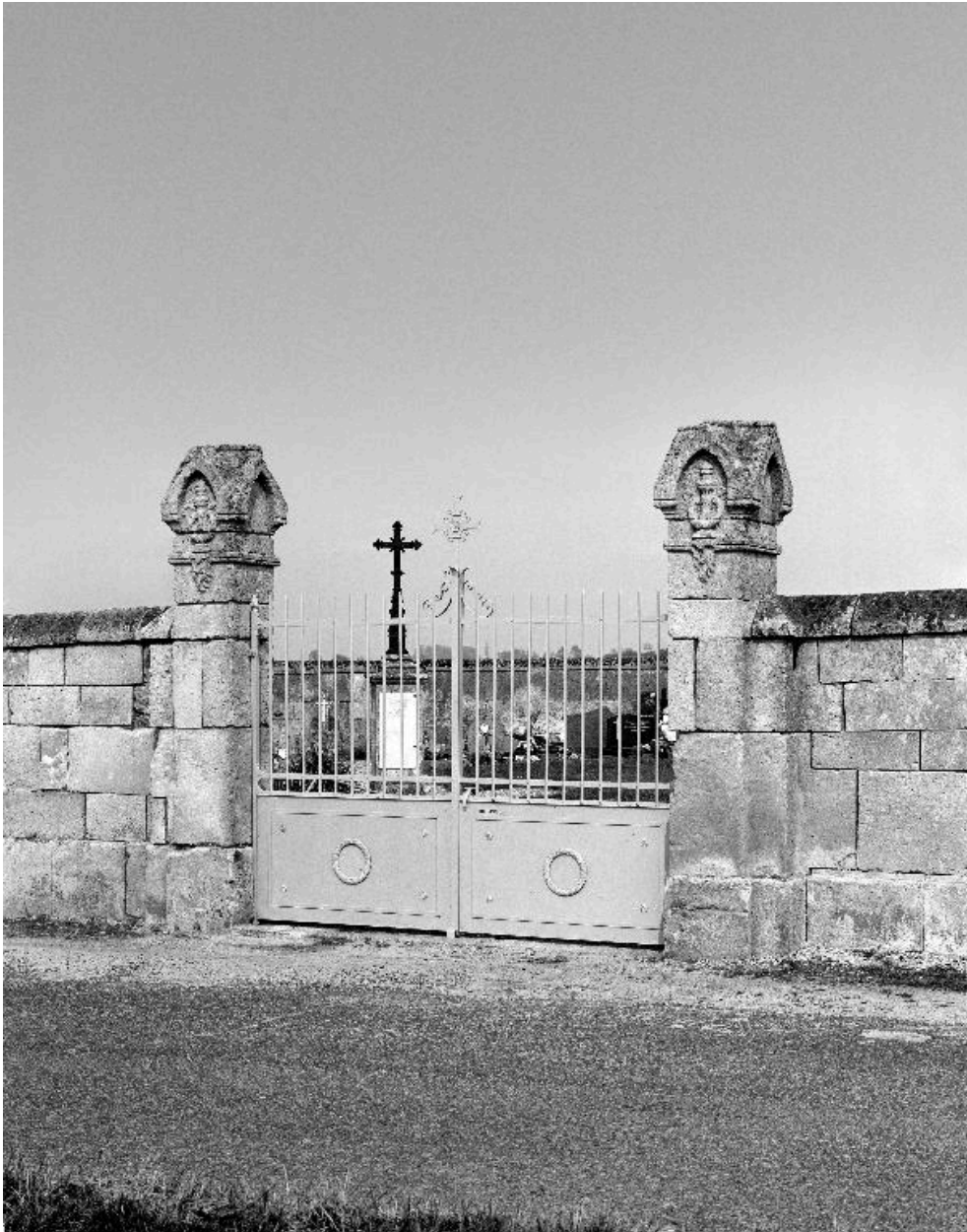
Vue de la porte d'accès.
