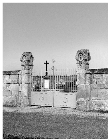
Vue de la porte d'accès. Phot. Thierry Lefébure IVR22_19900200878V
