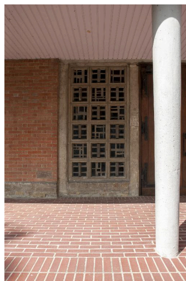
Vue d'un pilier de la galerie, à gauche de l'entrée. Phot. Pierre Thibaut IVR31_20155900360NUCA
