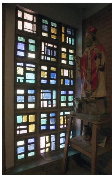
Verrière du baptistère. Phot. Pierre Thibaut IVR31_20155900370NUCA
