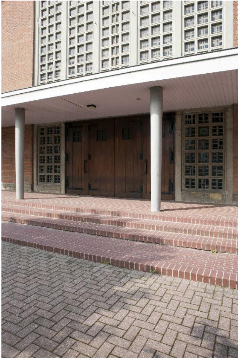
Vue partielle de la galerie accolée à la façade de l'église.
