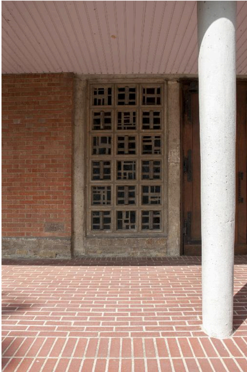
Vue d'un pilier de la galerie, à gauche de l'entrée.
