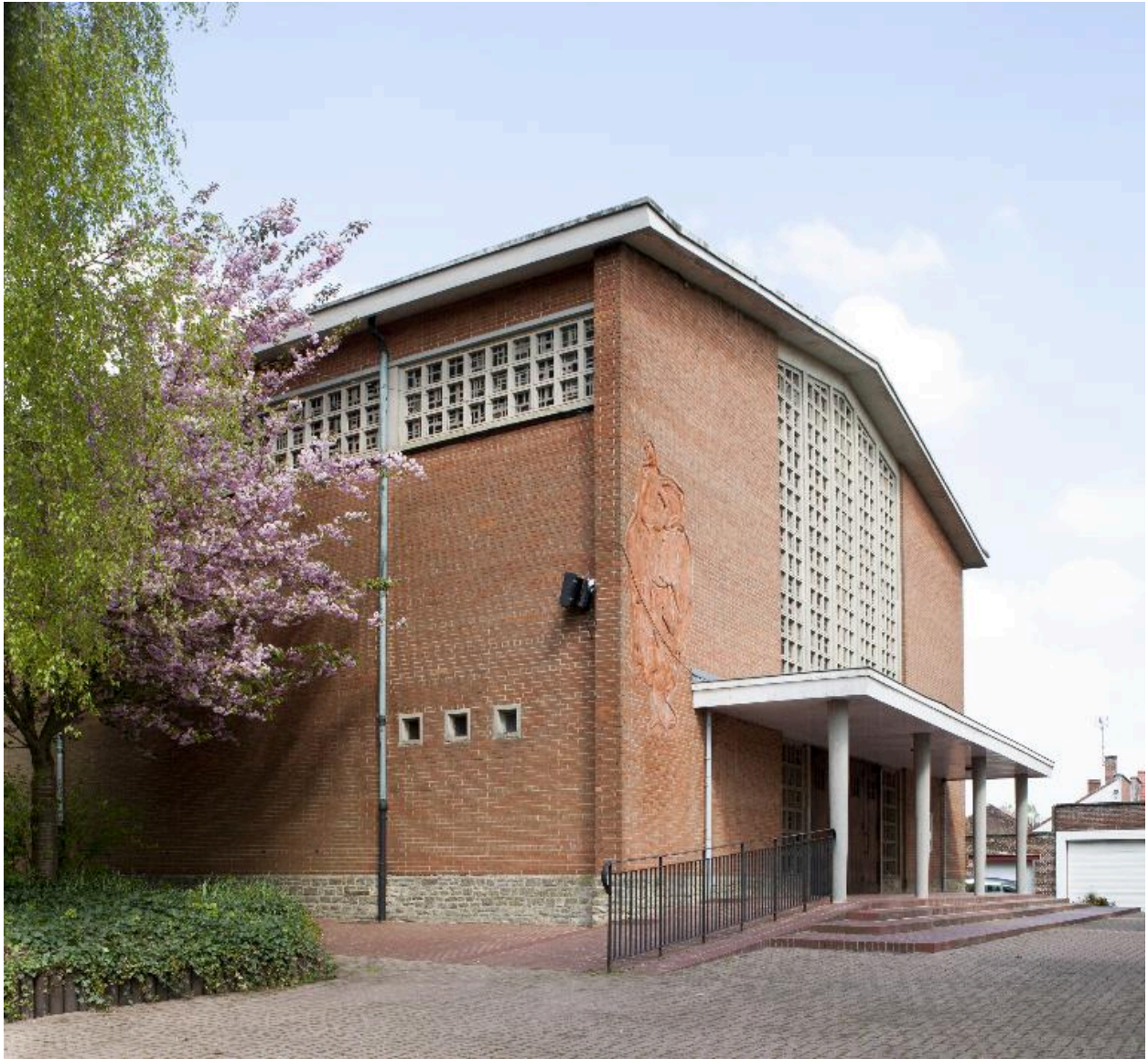
Vue trois-quart entrée église et flanc gauche.
