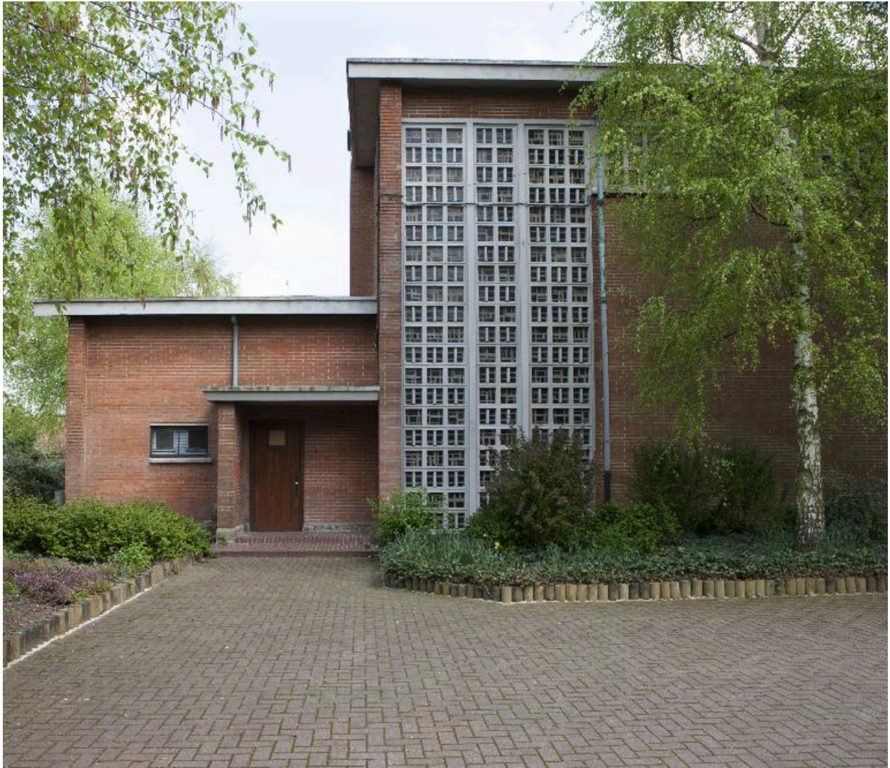
Vue latérale flanc gauche, entrée de la sacristie.
