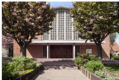
Élévation antérieure de l'église. Phot. Pierre Thibaut IVR31_20155900357NUCA
