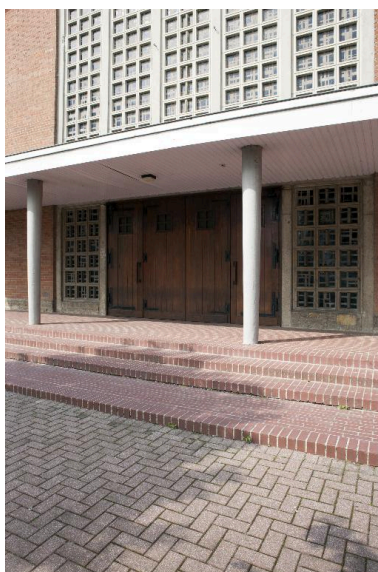
Vue partielle de la galerie accollée à la façade de l'église. Phot. Pierre Thibaut IVR31_20155900358NUCA
