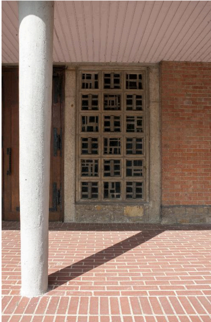
Vue d'un pilier de la galerie, à droite de l'entrée.
