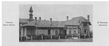
Le service médical. Extrait de L'Architecture , 1924. Phot. Isabelle Barbedor IVR32_20210205187NUCA
