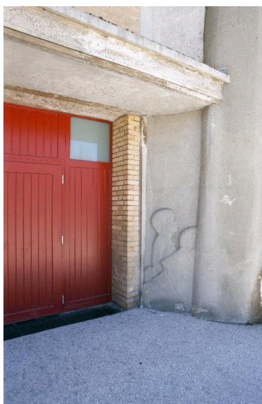
Détail droit du porche, côté ouest. Phot. Pierre Thibaut IVR31_20155900785NUCA
