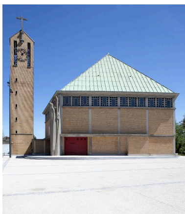
Élévation sud de l'église. Phot. Pierre Thibaut IVR31_20155900762NUCA
