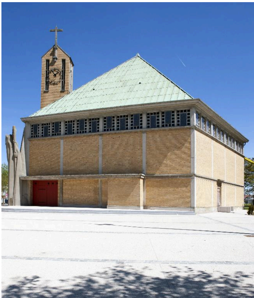
Élévation sud et est de l'église.
