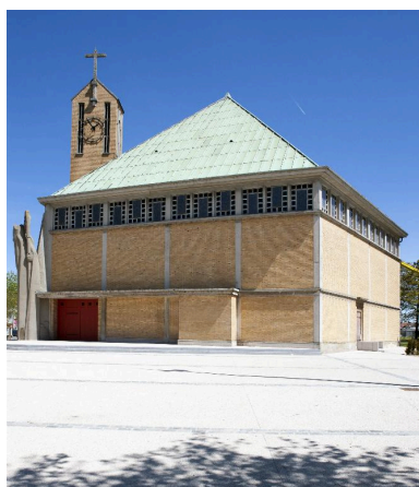
Élévation sud et est de l'église. Phot. Pierre Thibaut IVR31_20155900763NUCA
