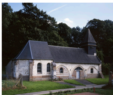
L'église Saint-Martin. Phot. Irwin Leullier IVR22_19988000822VA
