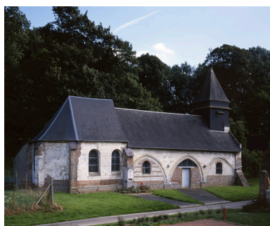
L'église Saint-Martin. Phot. Irwin Leullier IVR22_19988000822VA
