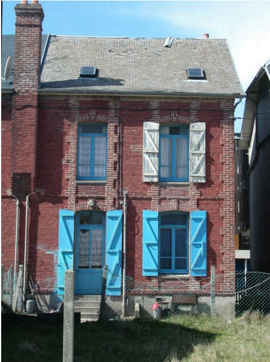
Détail de l'élévation postérieure d'un des deux logements.
