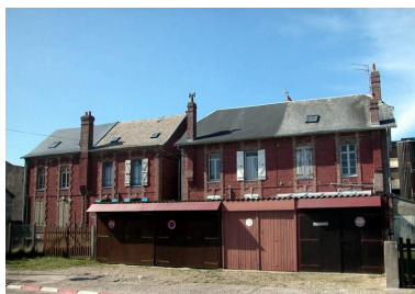
Façades postérieures, vue depuis la rue Saint-Martin. Phot. Elisabeth Justome IVR22_20058003915NUCA
