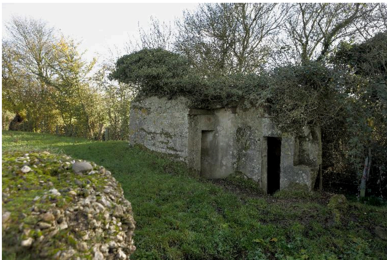
Vue de trois-quarts, vers le sud-est
