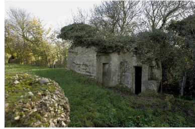
Vue de trois-quarts, vers le sud-est Phot. Jean-Marc Ramette IVR31_20145904886NUCA
