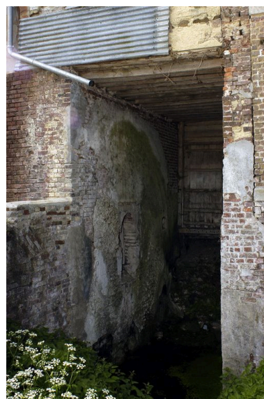
La cage du moulin. Phot. Thierry Lefébure IVR22_20056000050NUCA
