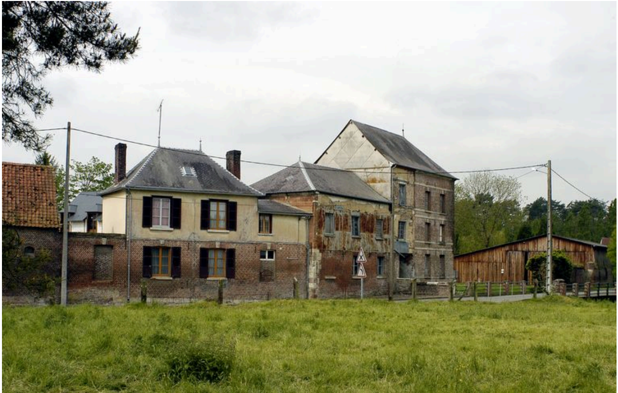
Vue d'ensemble sur rue.
