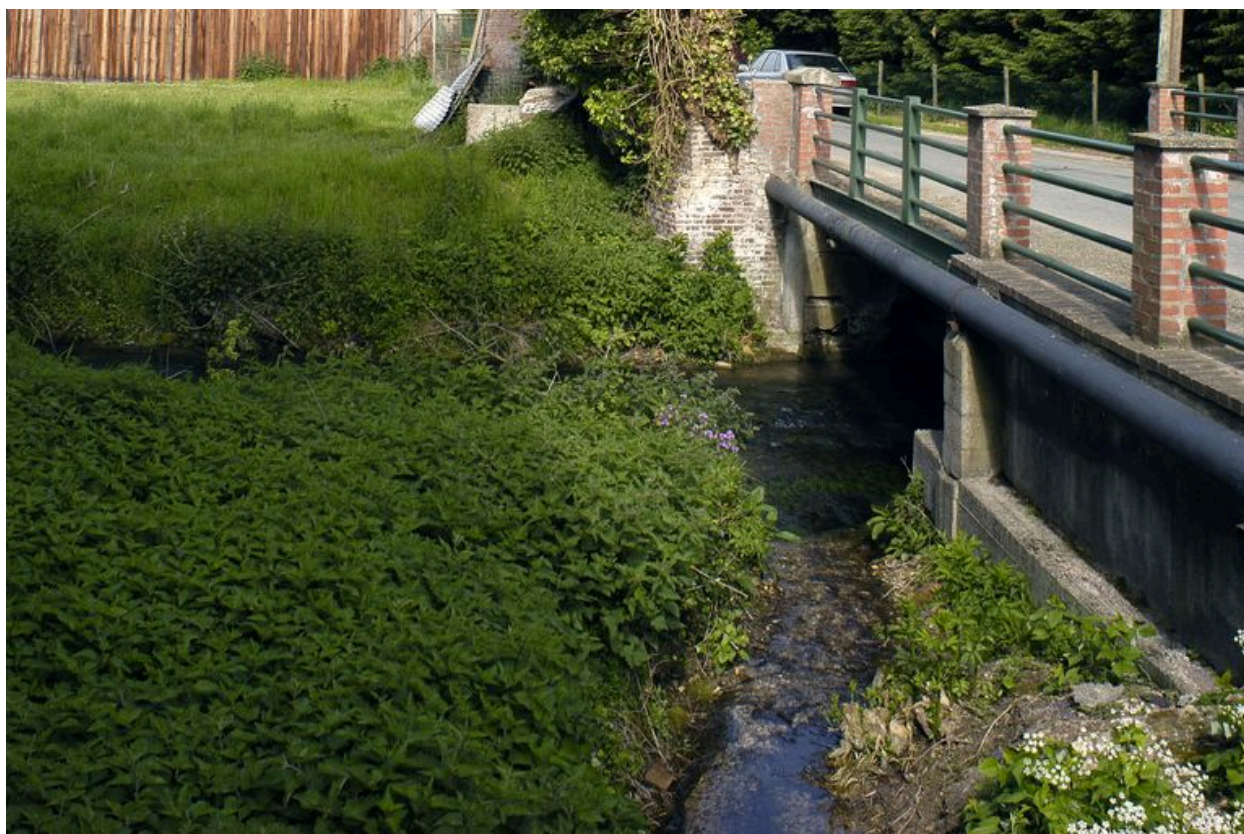
Le canal de fuite.
