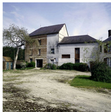
Vue d'ensemble sur cour. Phot. Thierry Lefébure IVR22_20056000100XA
