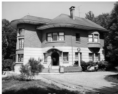
Elévation vers l'Est. Phot. Olivier Marlard IVR31_19955900525X
