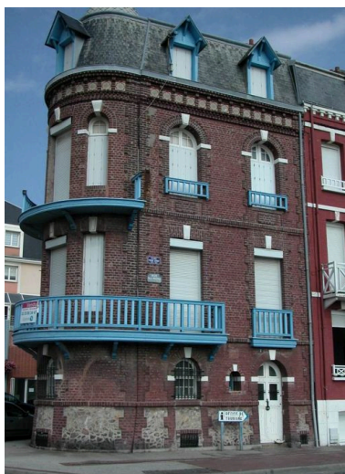
Elévation sur la rue Marcel-Holleville. Phot. Elisabeth Justome IVR22_20038005379NUCA
