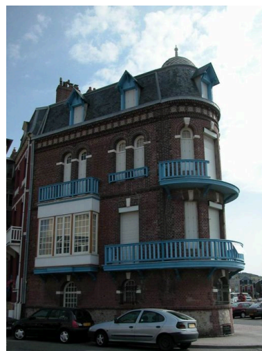
Elévation sur la rue Henri-Leboeuf. Phot. Elisabeth Justome IVR22_20038005381NUCA
