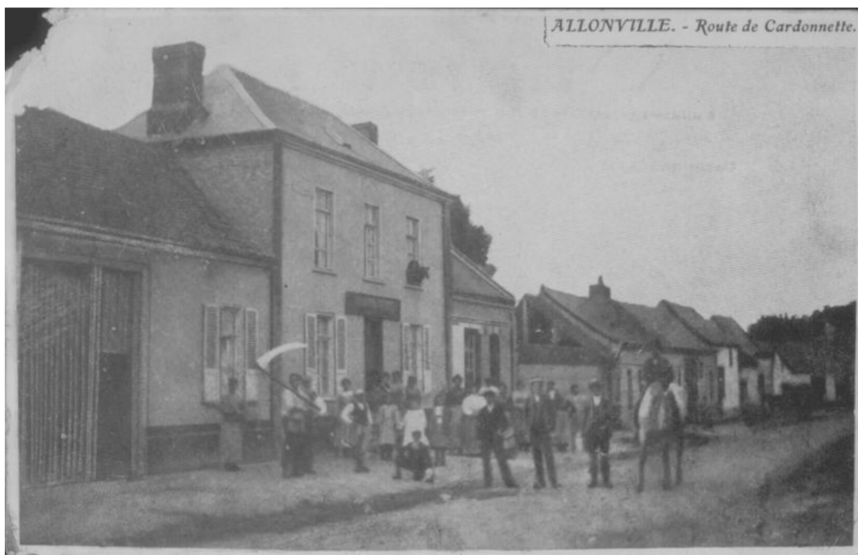
Allonville. Route de Cardonnette, 1er quart 20e siècle (AD Somme ; collection particulière).
