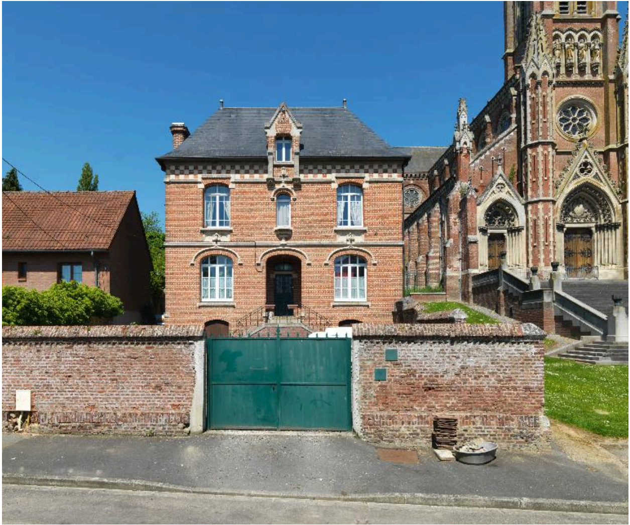
Façade sur cour, vue d'ensemble.
