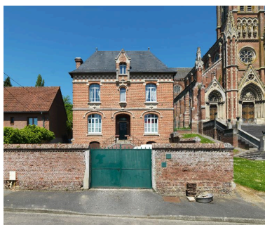
Façade sur cour, vue d'ensemble.
