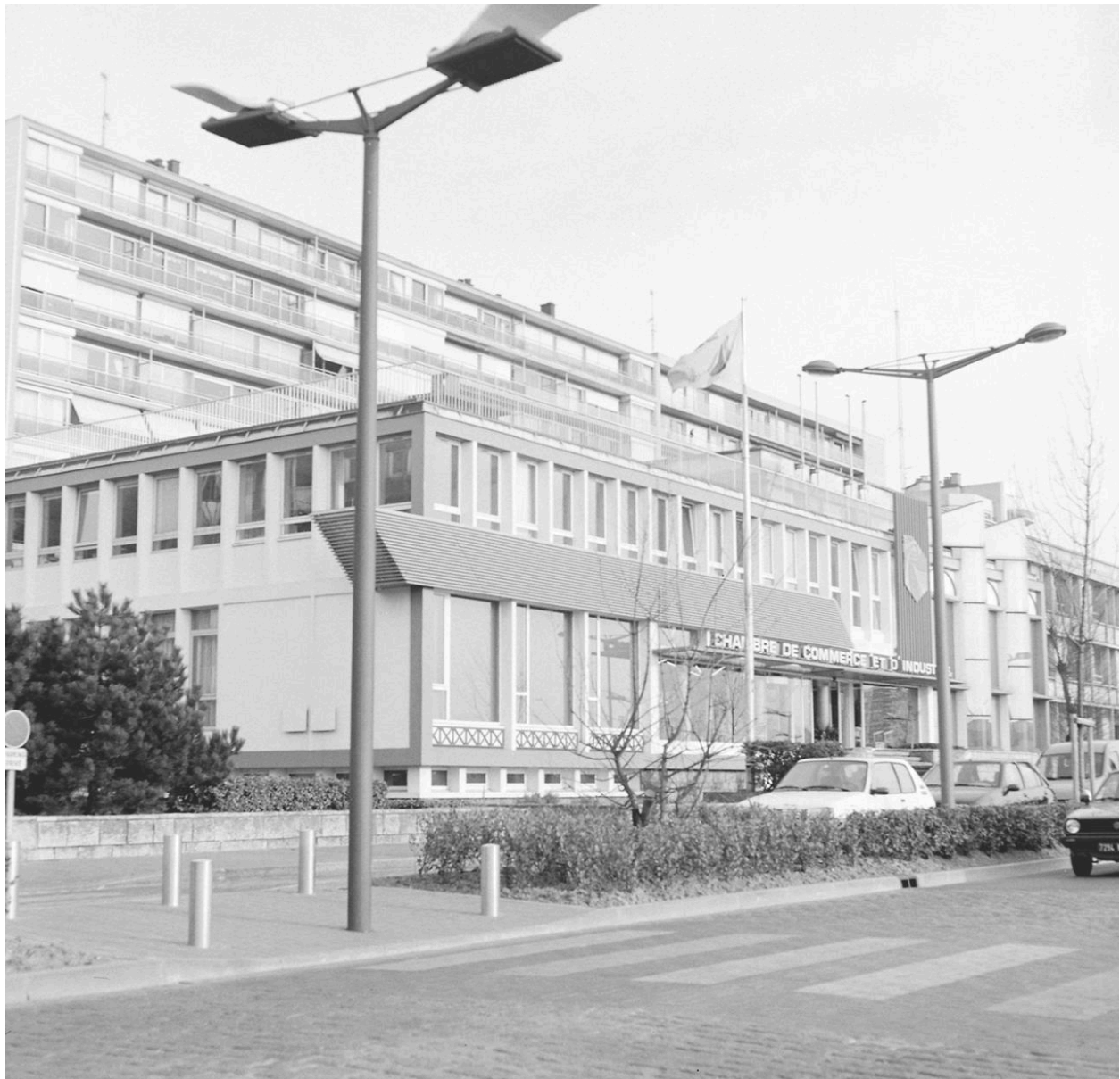
Vue d'angle sur quai de l'actuelle chambre de commerce.
