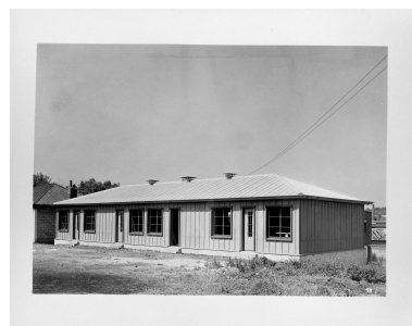
Baraquement réalisé en tôles provenant de la Fabrique de Fer de Maubeuge à Louvroil : maison-prototype Crames rue des Wiges à Louvroil, photographie ancienne, sans date (coll. part.).
