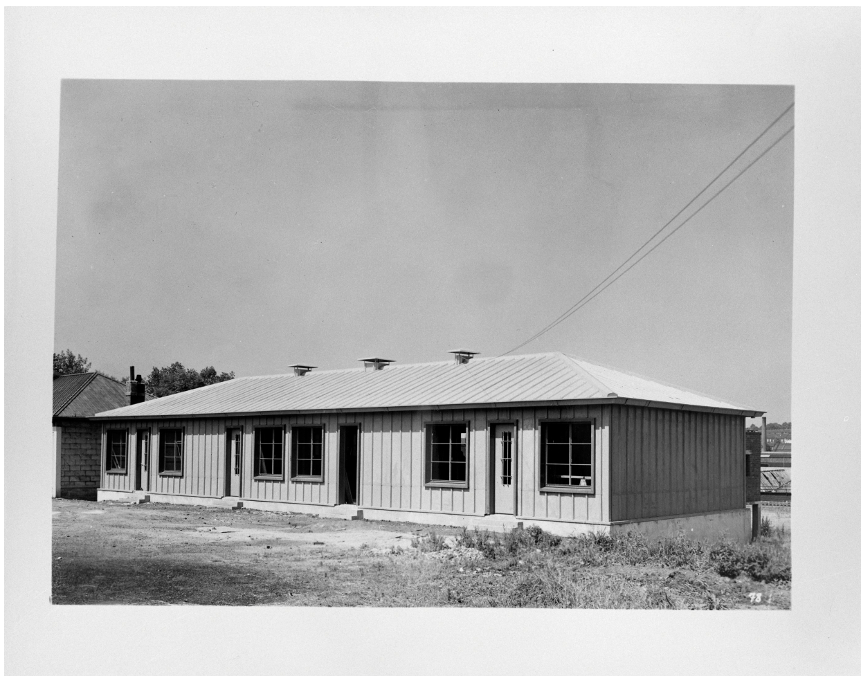
Baraquement réalisé en tôles provenant de la Fabrique de Fer de Maubeuge à Louvroil : maison-prototype Crames rue des Wiges à Louvroil, photographie ancienne, sans date (coll. part.).
