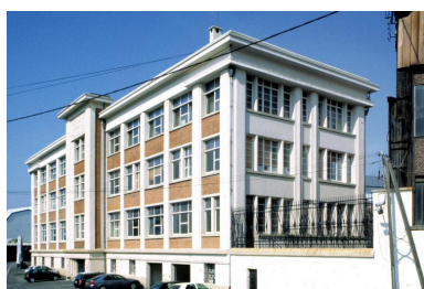
Vue générale des bureaux de la Fabrique de fer de Maubeuge devenue Tata Steel, situés avenue de l'Abbé Jean-de-Beco.
