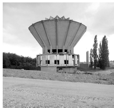
Vue générale du silo de dosage appelé le Dispatching, seul vestige de l'usine sidérurgique Usinor.
