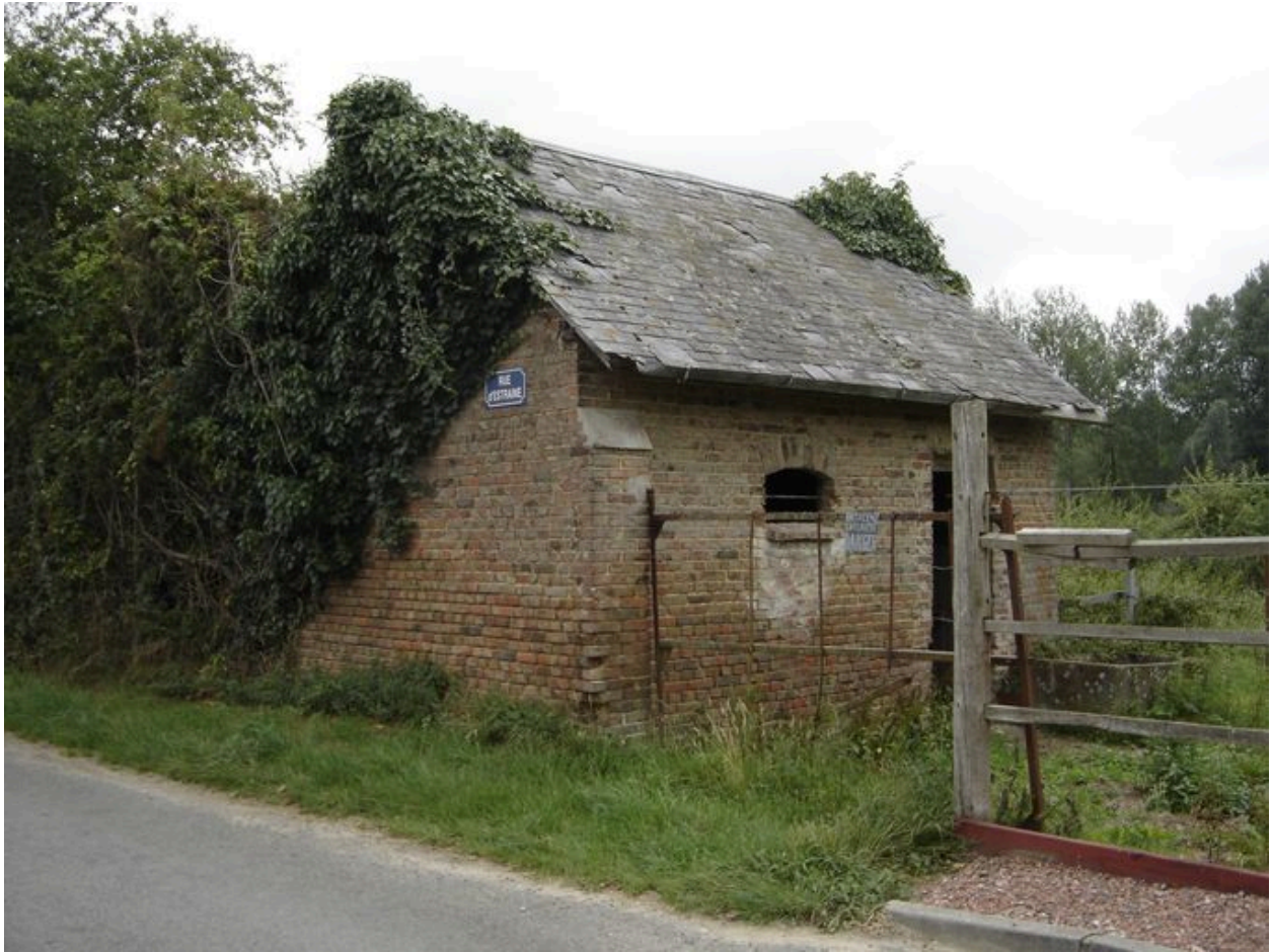
Vue de l'abri en brique dans la pâture.
