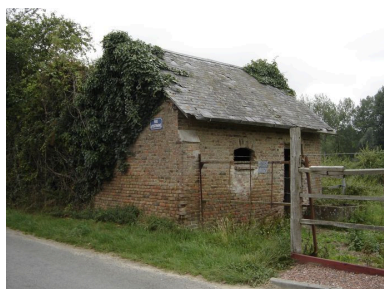
Vue de l'abri en brique dans la pâture. Phot. Inès Guérin IVR22_20068005036NUCA
