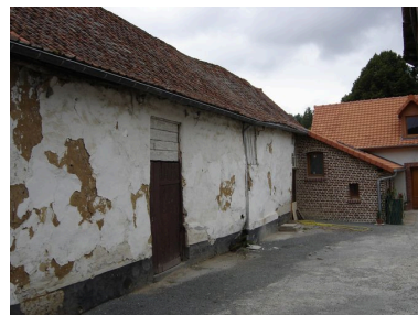
Vue du mur sur cour de la grange. Phot. Inès Guérin IVR22_20068005033NUCA
