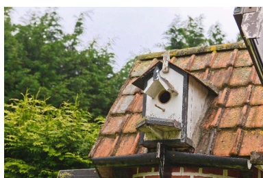
Moulin : détail de la toiture. Phot. Hubert Bouvet IVR31_20146202509NUC4A
