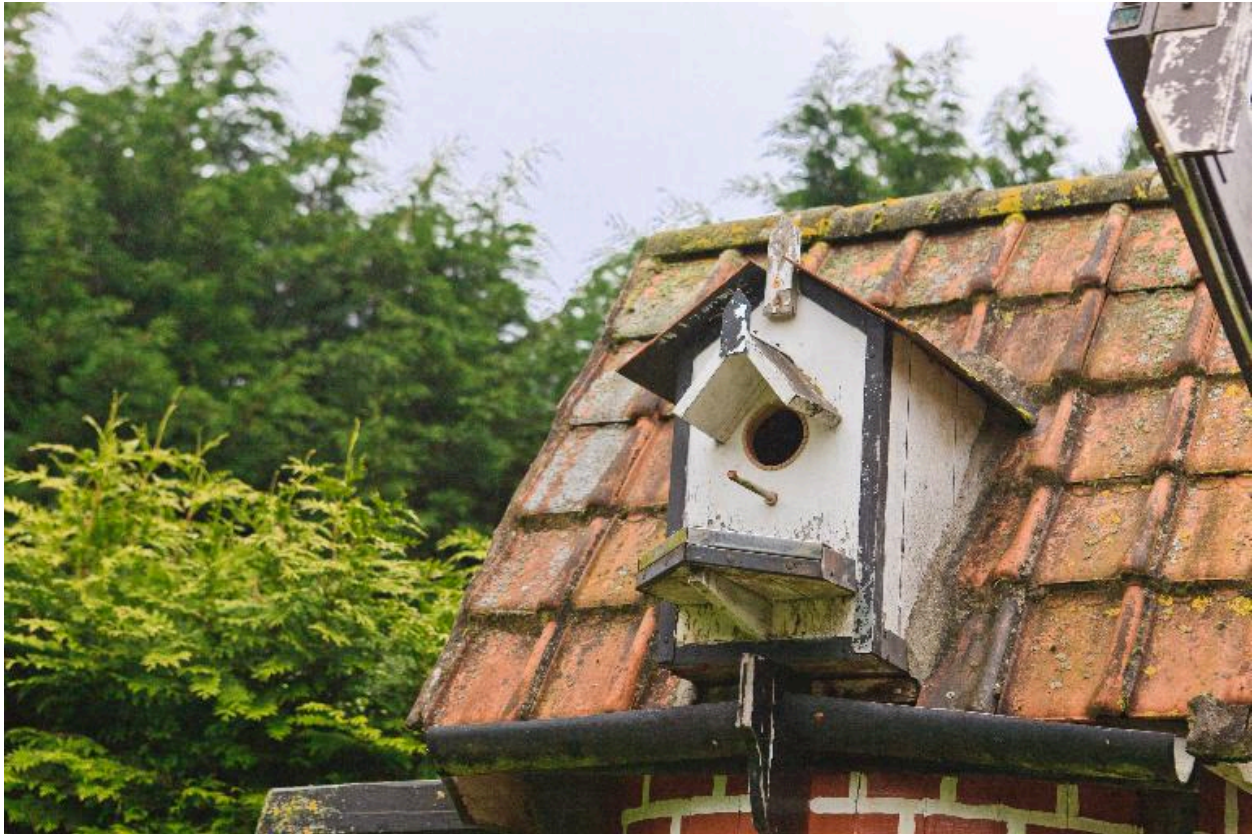
Moulin : détail de la toiture.
