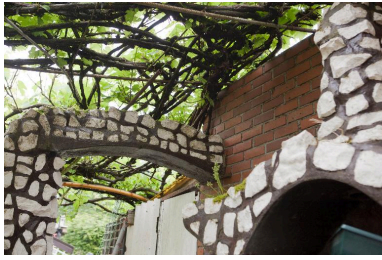
Vue de la cour, détail. Phot. Hubert Bouvet IVR31_20146202540NUC4A
