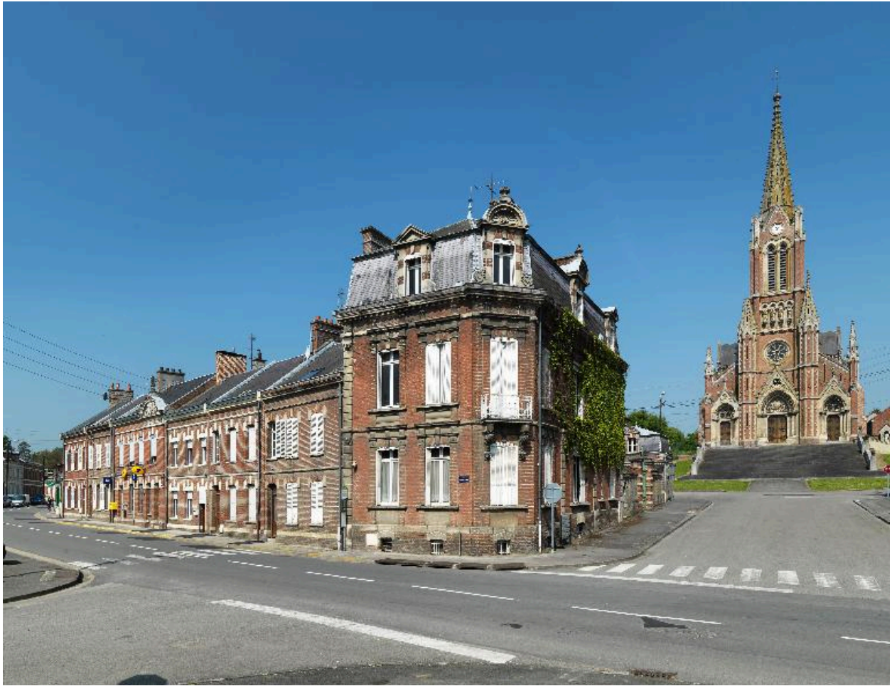
Vue d'ensemble vers l'ouest, avec l'église paroissiale en arrière plan de la rue perpendiculaire.
