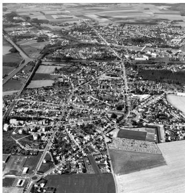
Vue aérienne vers l'ouest, en 1992. Fargniers, Tergnier et Vouël. Phot. Phot'R IVR22_19920202616P
