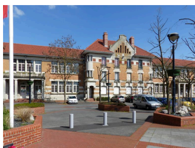
Le groupe scolaire André-Malraux de Tergnier. Phot. Isabelle Barbedor IVR32_20210205007NUCA
