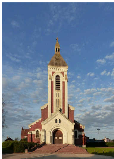
Eglise Saint-Martin de Vouël. Phot. Isabelle Barbedor IVR32_20210205087NUCA
