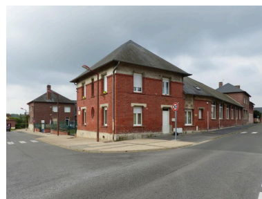
Le groupe scolaire de Quessy. Phot. Isabelle Barbedor IVR32_20210205120NUCA
