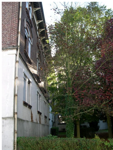
Façade sud, vue depuis le sud-est. Phot. Isabelle Barbedor IVR22_20048010498NUCA
