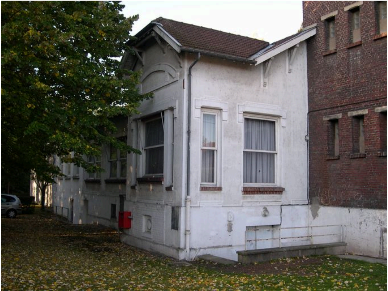
Ancienne salle de lecture, façade est, vue depuis le nord-est.
