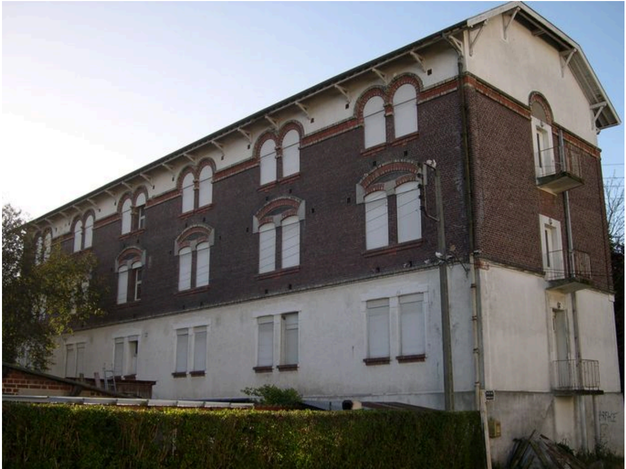
Façade nord, vue depuis le nord-est.
