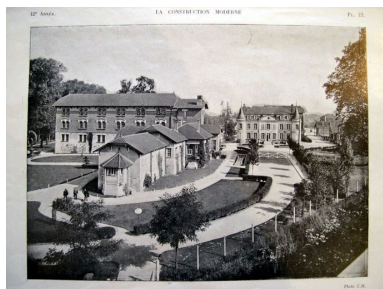
Longueau. Foyer-hôtel de la Compagnie du Nord (pl. 13). La construction Moderne, n° 4, 24 octobre 1926. Phot. Isabelle Barbedor IVR22_20048010784NUCA
