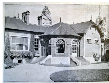
Gare de Longueau. Entrée du Foyer-hôtel. La construction Moderne, n° 4, 24 octobre 1926. Phot. Isabelle Barbedor IVR22_20048010786NUCA
