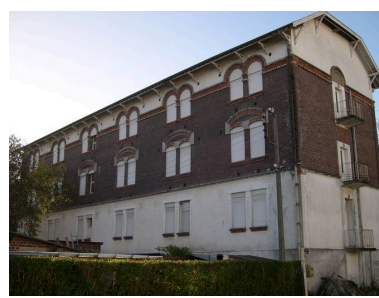
Façade nord, vue depuis le nord-est. Phot. Isabelle Barbedor IVR22_20048010497NUCA
