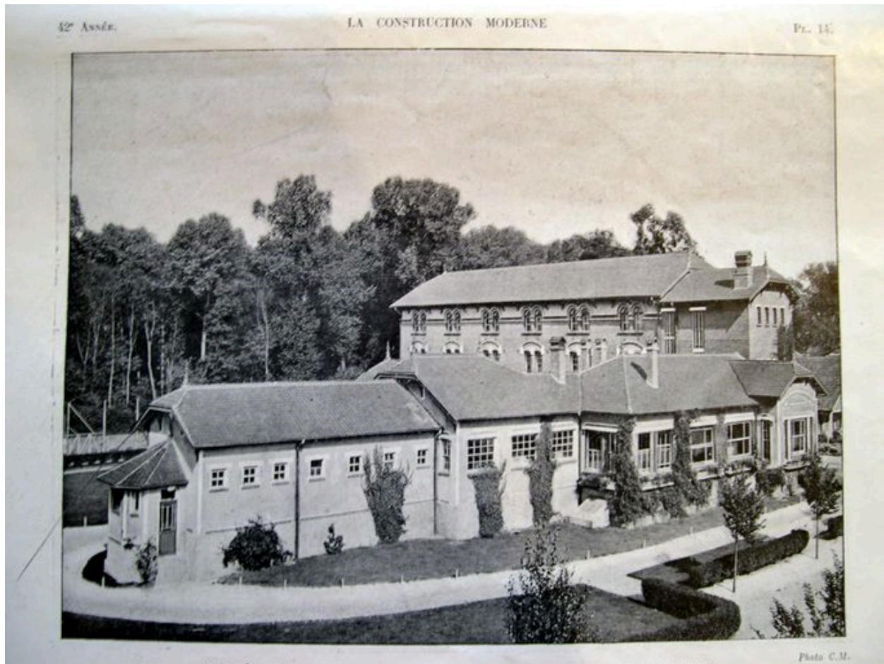
Longueau. Foyer-hôtel de la Compagnie du Nord (pl. 14). La construction Moderne, n° 4, 24 octobre 1926.
