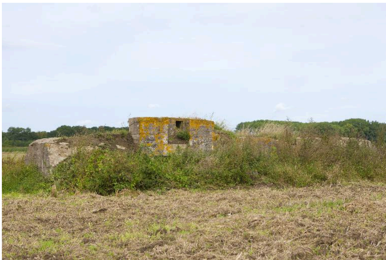
Vue antérieure, vers le nord-ouest
