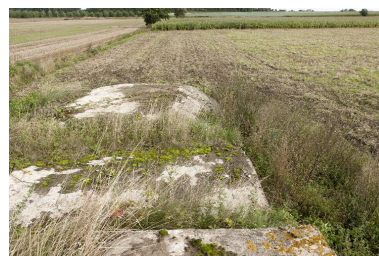
Depuis le couvrement, vers le nord-est Phot. Jean-Marc Ramette IVR31_20146203062NUCA
