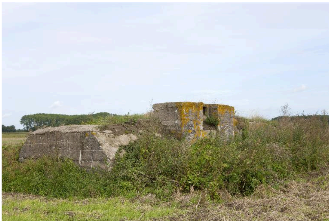
Vue de trois-quarts vers le nord
