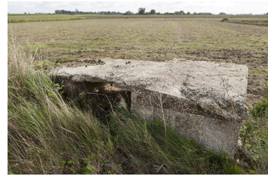
Depuis le couvrem., le poste de tir vers le sud-est Phot. Jean-Marc Ramette IVR31_20146203061NUCA
