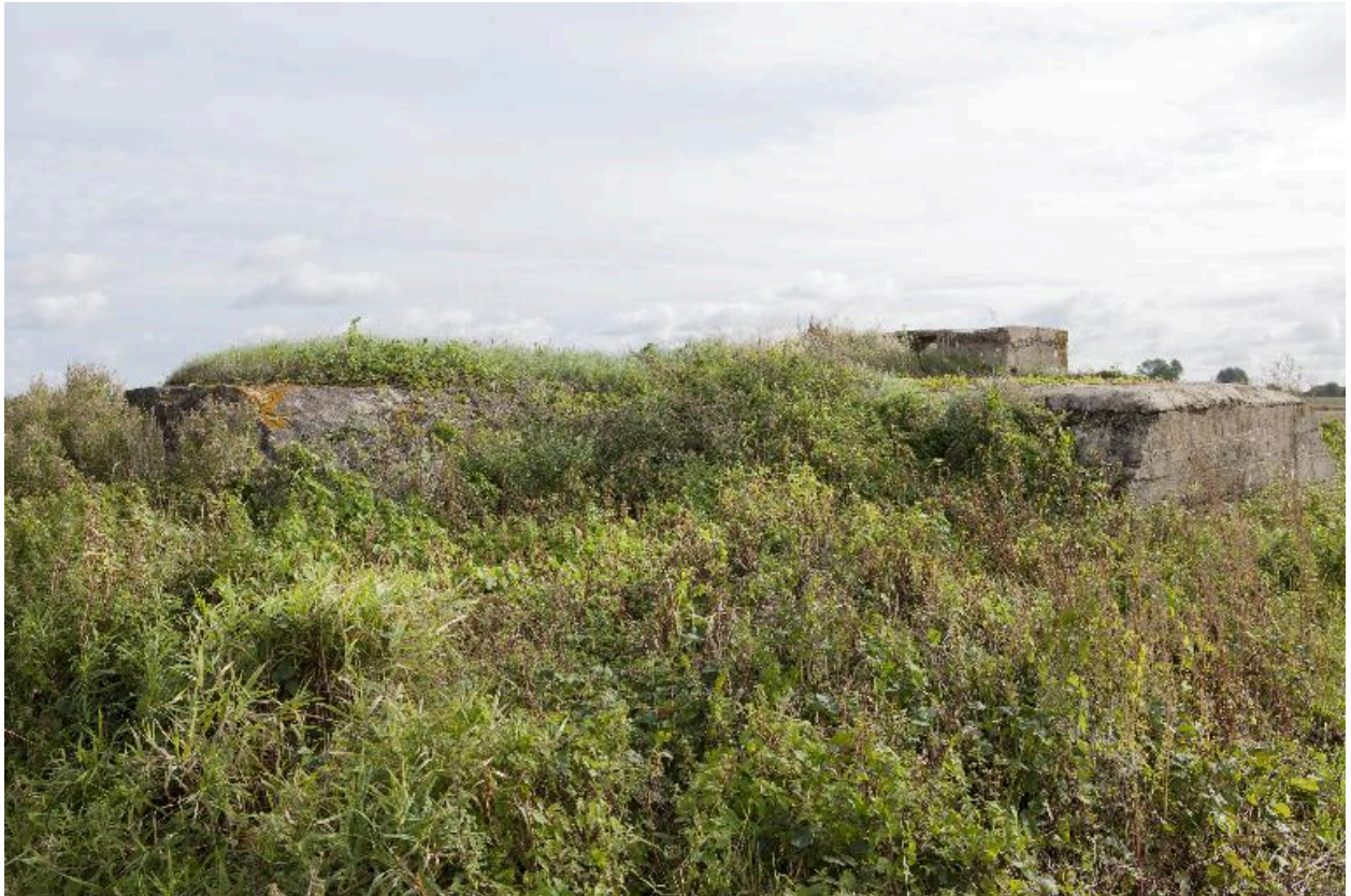
Vue postérieure, vers le sud-est
