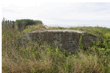
Vue latérale, vers sud-ouest Phot. Jean-Marc Ramette IVR31_20146203050NUCA
