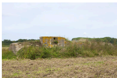
Vue antérieure, vers le nord-ouest Phot. Jean-Marc Ramette IVR31_20146203042NUCA
