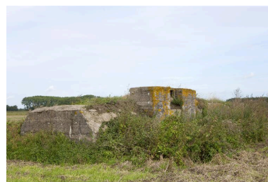
Vue de trois-quarts vers le nord Phot. Jean-Marc Ramette IVR31_20146203044NUCA
