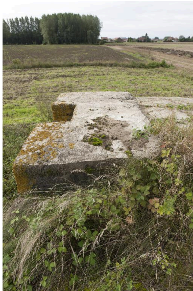
Depuis le couvrem., vue latérale du poste de tir, vers le sud-ouest Phot. Jean-Marc Ramette IVR31_20146203064NUCA
