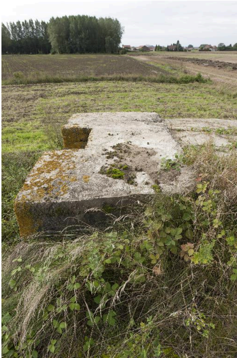
Depuis le couvremet., vue latérale du poste de tir, vers le sud-ouest
