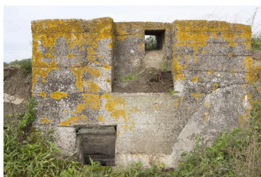
Poste de tir avec, à gauche, la resserre à mitrailleuse Phot. Jean-Marc Ramette IVR31_20146203046NUCA
