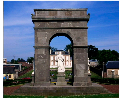
Vue postérieure du monument avec la demeure de l'industriel à l'arrière-plan. Phot. Martine Plouvier IVR22_19948000491ZA
