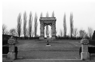
Vue de situation. Phot. Judith Förstel IVR22_19968000136Z
